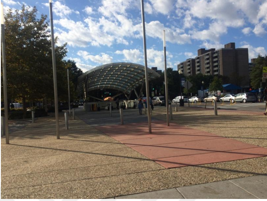
Fotoğraf 145: Metro İstasyonu Giriş Alanı
