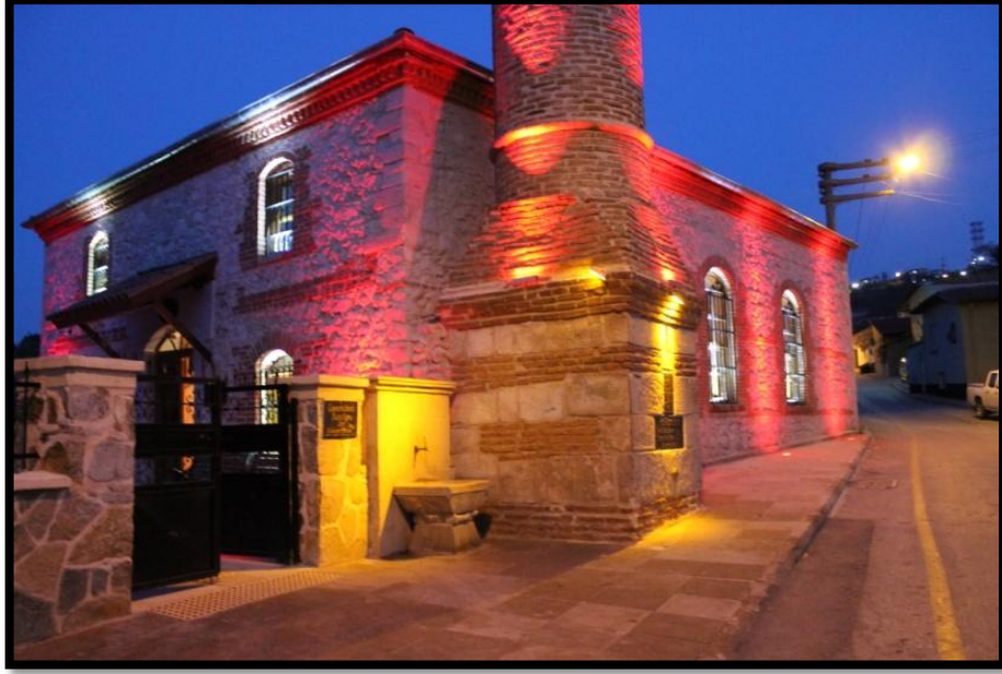
Şekil 26. Cami Gece Aydınlatması
