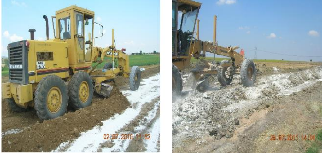
Resim 1.2.'de zemine kireç serilmesi ve greyder ile karıştırılması gösterilmektedir.
