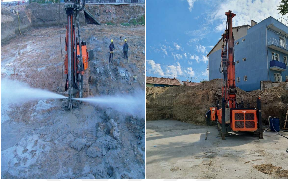
Resim 1.1. Araştırma sondaj kuyuları imalat aşamaları (Geçerli olan geoteknik rapordan alınmıştır)
