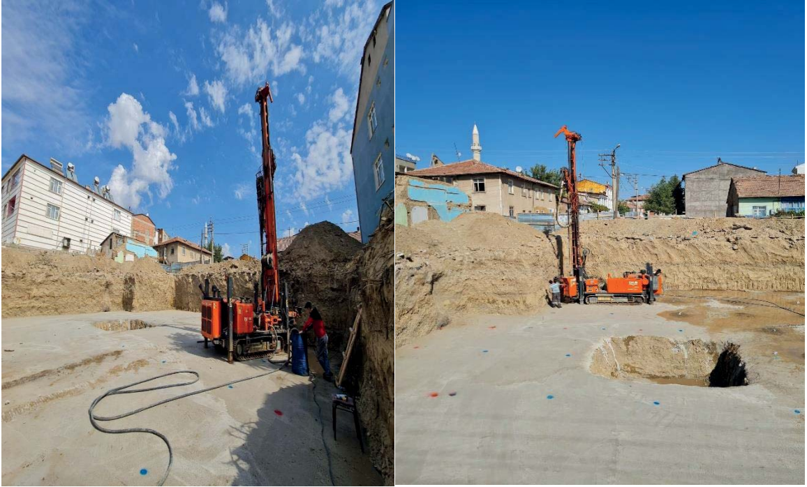
Resim 2.2. Delgi işlemi esnasında ve delgi işlemi sonrasında (URL-3, 2020)
