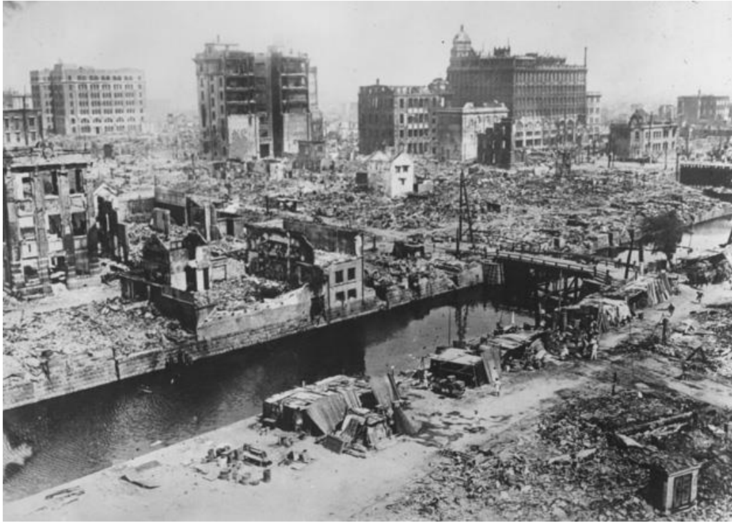
Şekil 2.3 : Nihombashi'de enkazlar, Büyük Kanto Depremi, 1923.
