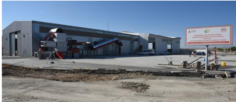
Şekil 3.10. Katı atık ön işlem ve kompost tesisi.
