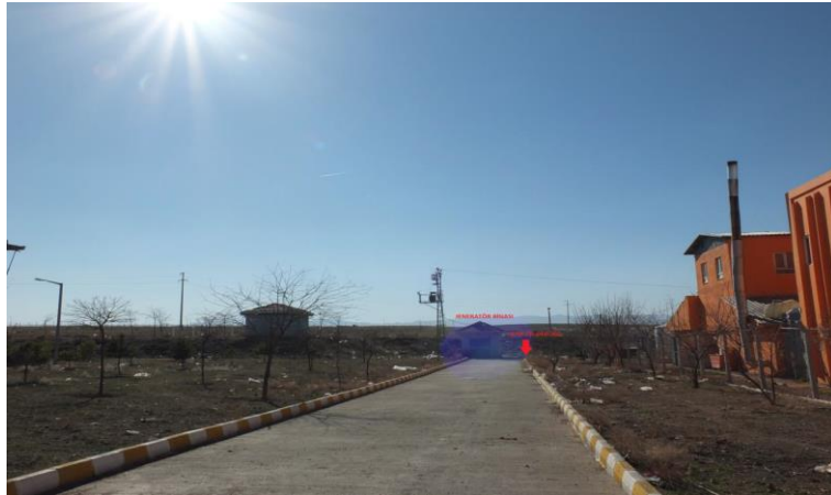
Şekil 3.6. Jeneratör binası ve atık pil geçici depolama hücresi.
