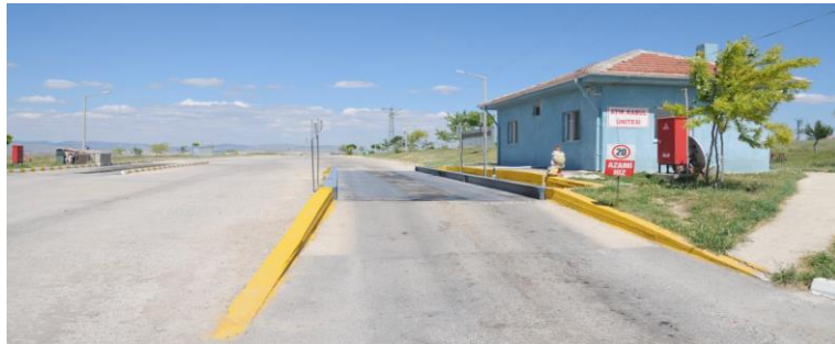
Şekil 3.3. Atık kabul merkezi ve kantar binası.
