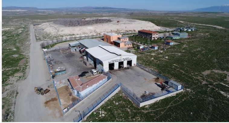
Şekil 3.2. Tesis üstten görünüm II.
