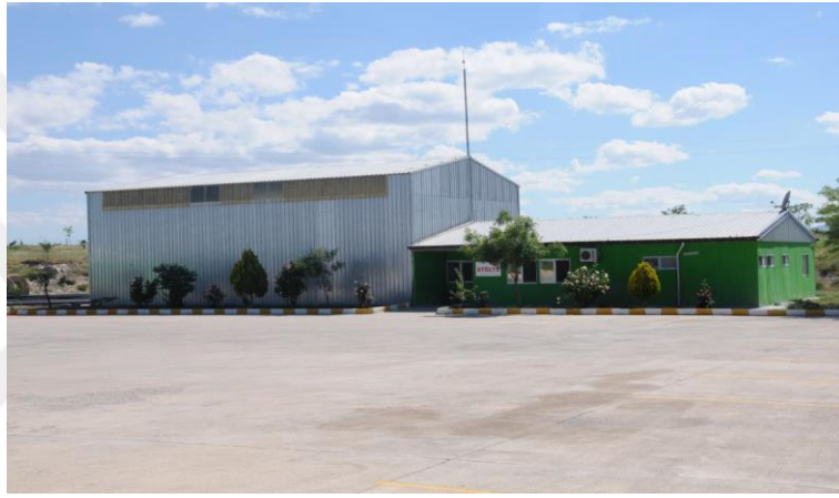
Şekil 3.5. Tamir bakım atölye binası.
