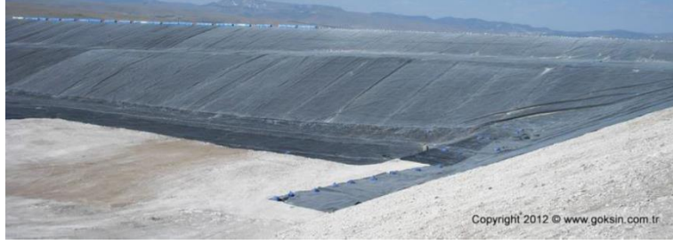
Şekil 3.7. Lot 1A taban izolasyonu.
