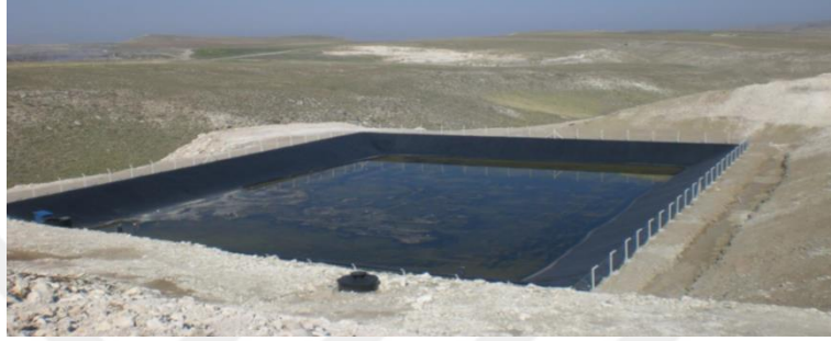
Şekil 3.8. Sızıntı suyu toplama havuzu.
