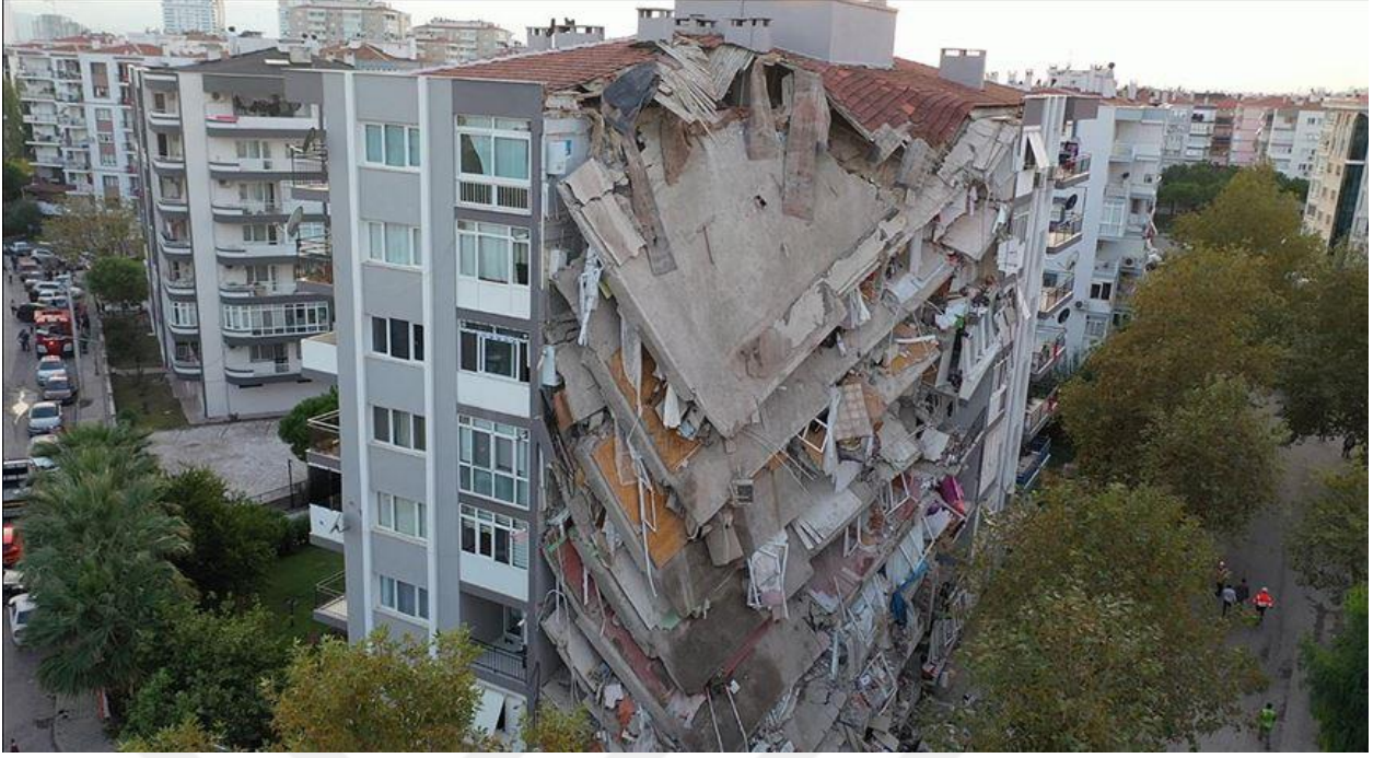
Şekil 1.4. İzmir depremi sonrası yarısı çöken bina
