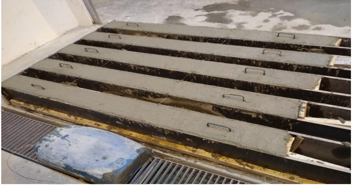
Şekil.3. 6. Projede Kullanılan Betonun Kalıplara Dökülmesi
