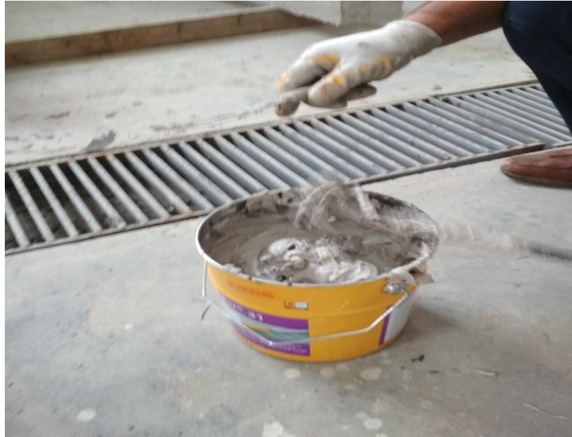
Şekil.3. 13.Epoksinin Karıştırılması
