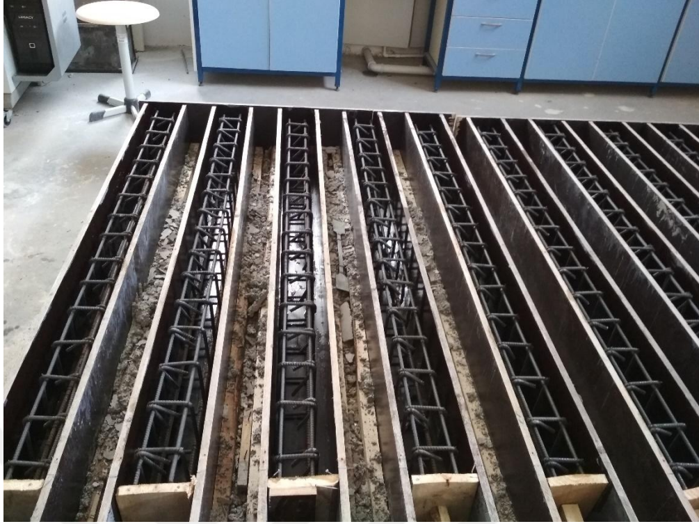
Şekil.3. 5.Projede Kullanılacak Donatıların Hazırlanması
