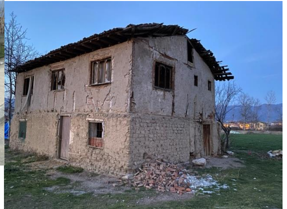
Resim 10 Depremlerden Sonra Günümüze Kadar Gelmiş Eski Erbaa Evleri (Soldaki Restore Edilmiştir)
