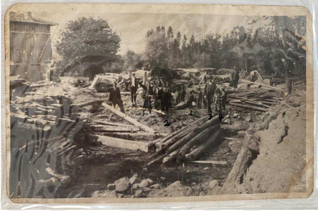
Resim 7 Depremden Sonra Enkaz Kaldırma Çalışmaları Yapılırken (Kaynak kişimiz Hayri DOĞAN Bey'in Fotoğraf Albümünden)
