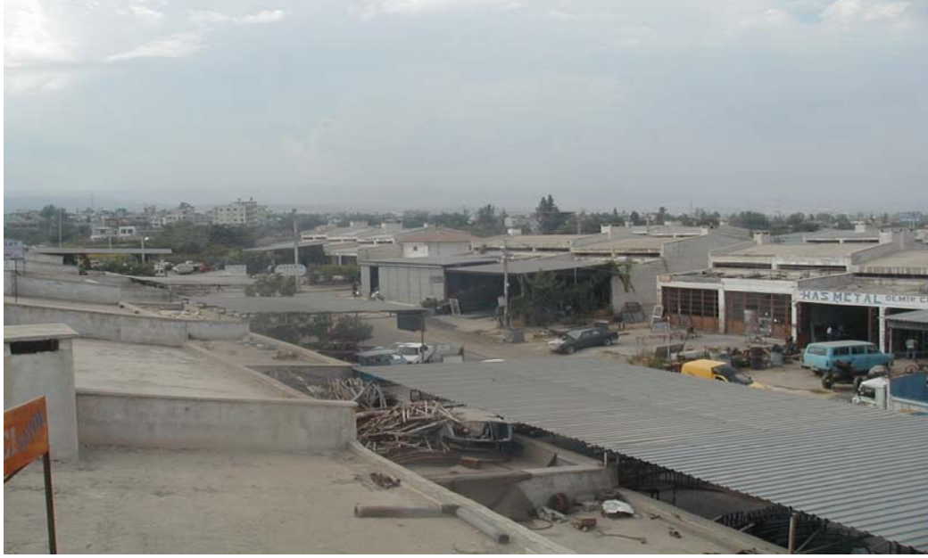
Şekil 4.29. Sanayi bölgesinin kuzeye bakan bölümü
