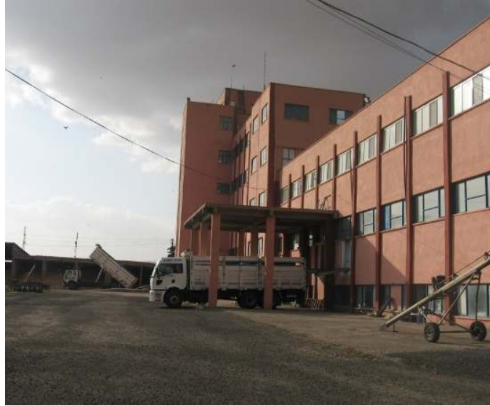
Foto 48: Ergani Gıda ve Un fabrikası
