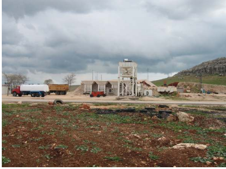
Foto 46: Kömürtaş Köyü yakınlarında limak çimento fabrikasına malzeme alınan şantiyeden bir görünüm.
