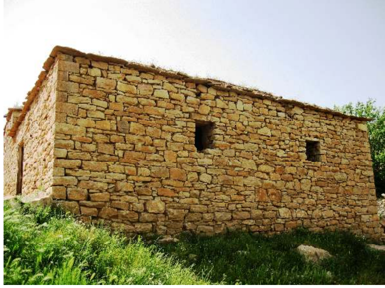
Foto 39: Ergani ovasında kalker bloklarının kesilerek konut inşa malzemesi olarak kullanıldığı bir yapı
