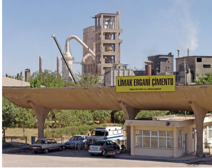
Foto 45: Ergani Limak Çimento fabrikası
