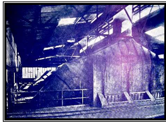
Resim 12 – Water Jacket fırını dolduruş kısmı (Bakır 1949 adlı eserden alınmıştır.)
