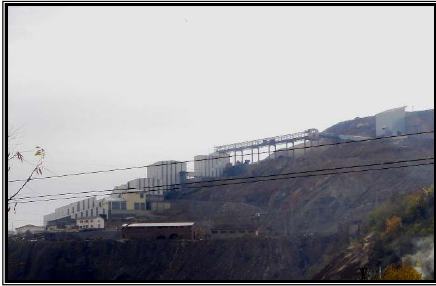
Resim 14 – 2009 yılında Ergani Bakır İşletmesi’nde kurulan yeni flotasyon tesisi
