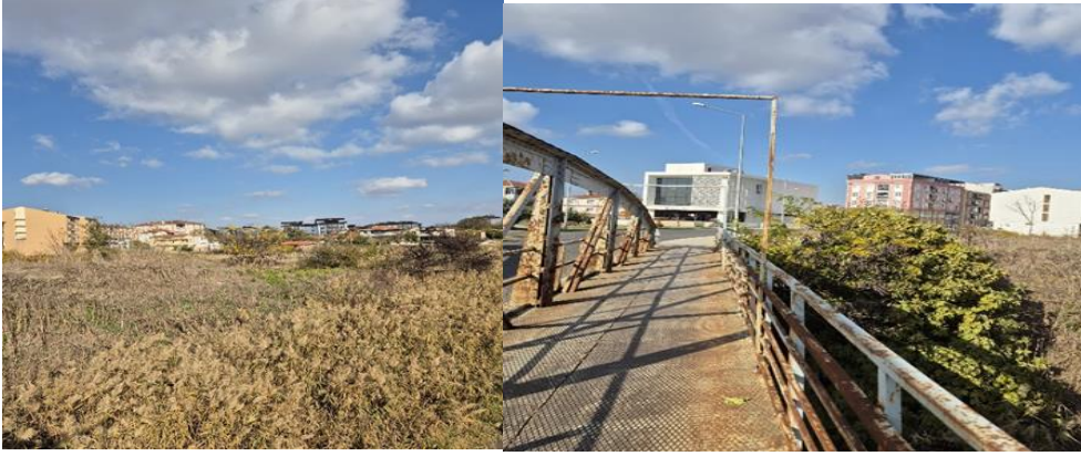
Resim 3.5. Muratlı Lise Köprüsü
