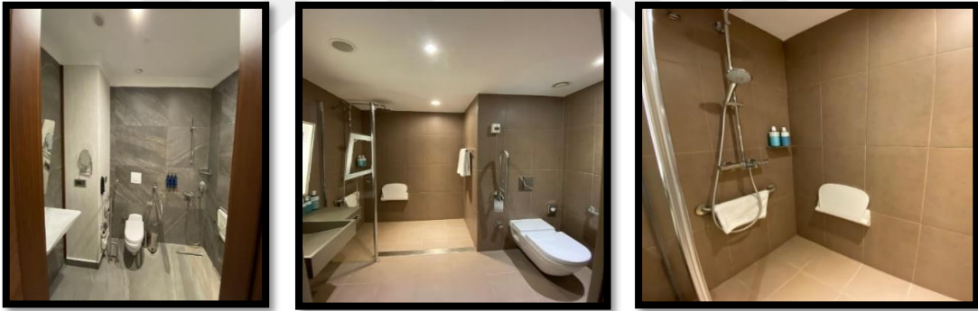
Şekil 5.5. Engelli duş kabinin iç tasarımı Kaynak: Bu fotoğraflar yazar tarafından çekilmiştir.
