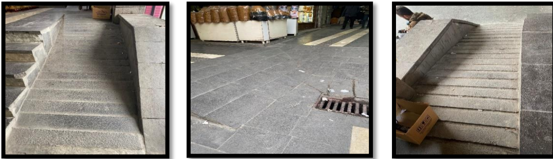
Şekil 4.2. Balıkçılarbaşı Kapalı Çarşısında ki kaldırım, merdiven ve rampa örnekleri Kaynak: Bu fotoğraf yazar tarafından çekilmiştir.
