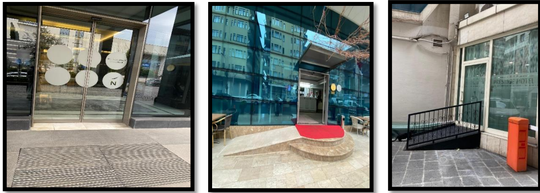
Şekil 5.8. Engelli bireyler için otel girişinde hissedilebilir uyarıcı zemin ve rampa örnekleri
