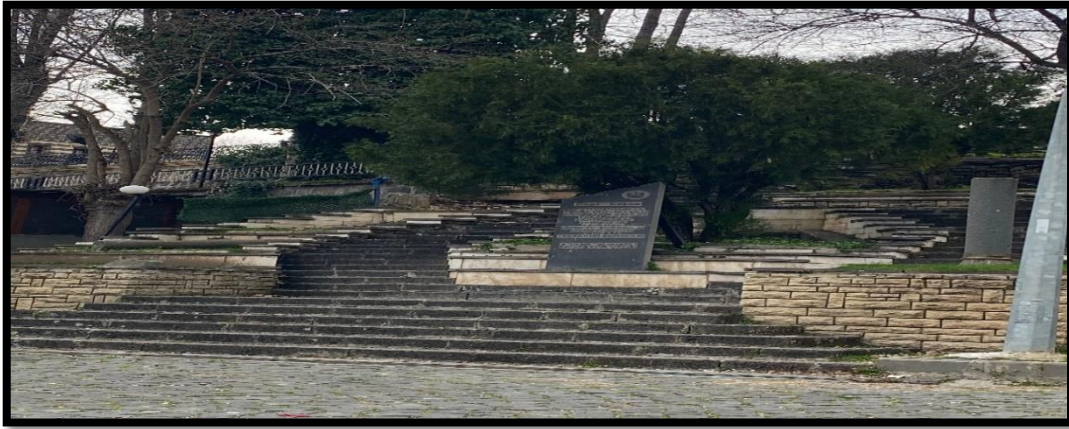
Şekil 4.4. Diyarbakır Gazi Köşkündeki kaldırım ve merdiven örnekleri
