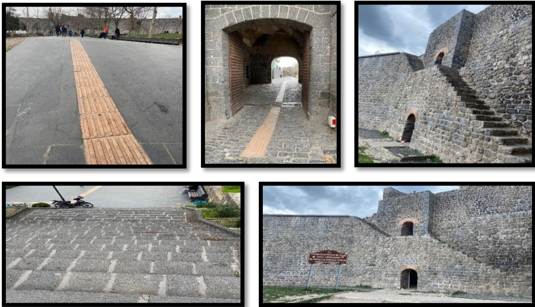
Şekil 4.3. Hız. Süleyman Cami'deki kaldırım, merdiven ve rampa örnekleri Kaynak: Bu fotoğraf yazar tarafından çekilmiştir.
