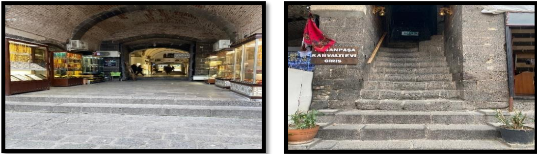
Şekil 4.6. Diyarbakir Hasan Paşa Hanındaki kaldırım, merdiven ve rampa örnekleri Kaynak: Bu fotoğraf yazar tarafından çekilmiştir.
