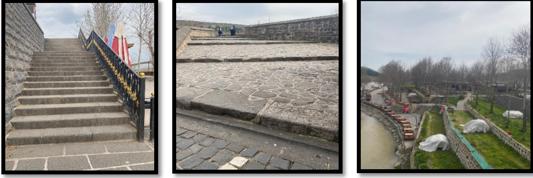
Şekil 4.5. Diyarbakir On Gözlu Köprüdeki kaldırım, merdiven ve rampa örnekleri Kaynak: Bu fotoğraf yazar tarafından çekilmiştir.
