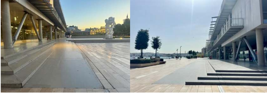
Şekil 28. İstanbul Modern Sahil ve. Karaköy Girişleri Engelli Rampası
