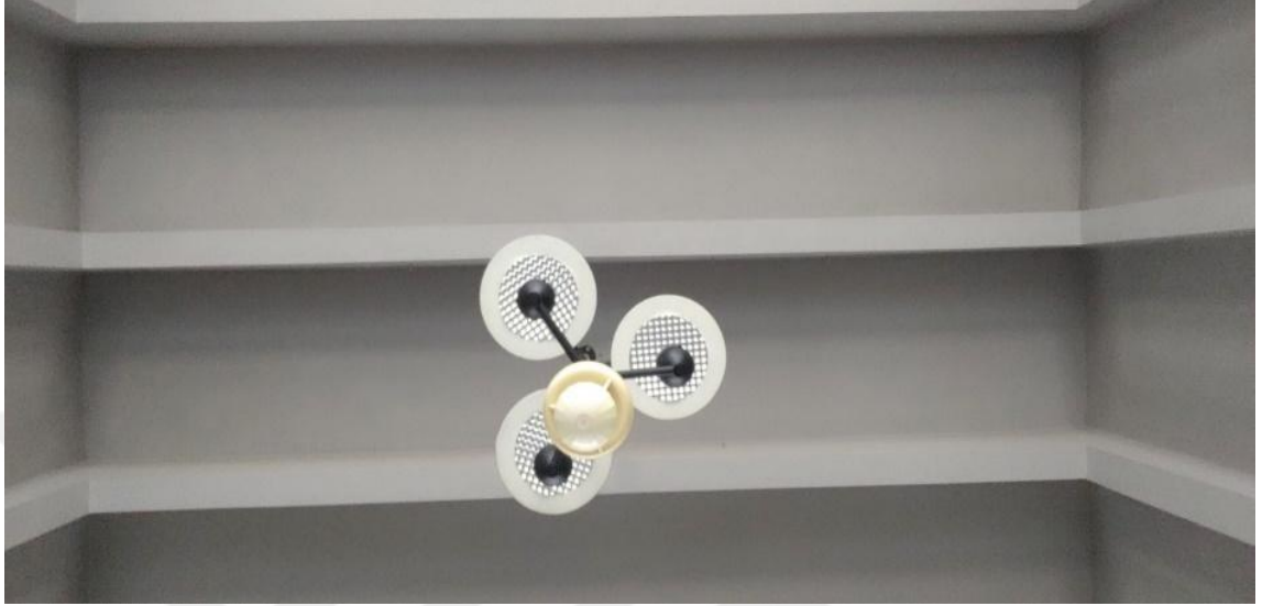
Resim 59. Erzurum Gar Binası bekleme salonunda yer alan aydınlatmanın onarım öncesi görünümü (İlknur Keleş)
