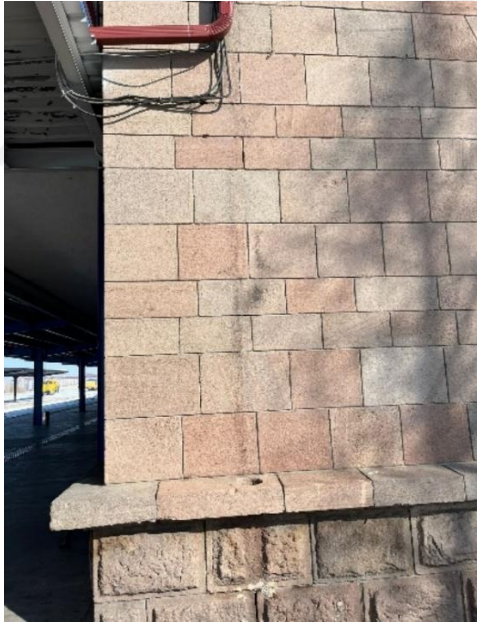
Resim 167. Erzurum Gar Binası cephede oluşan yüzeysel hasarların genel görünümü (İlknur Keleş)
