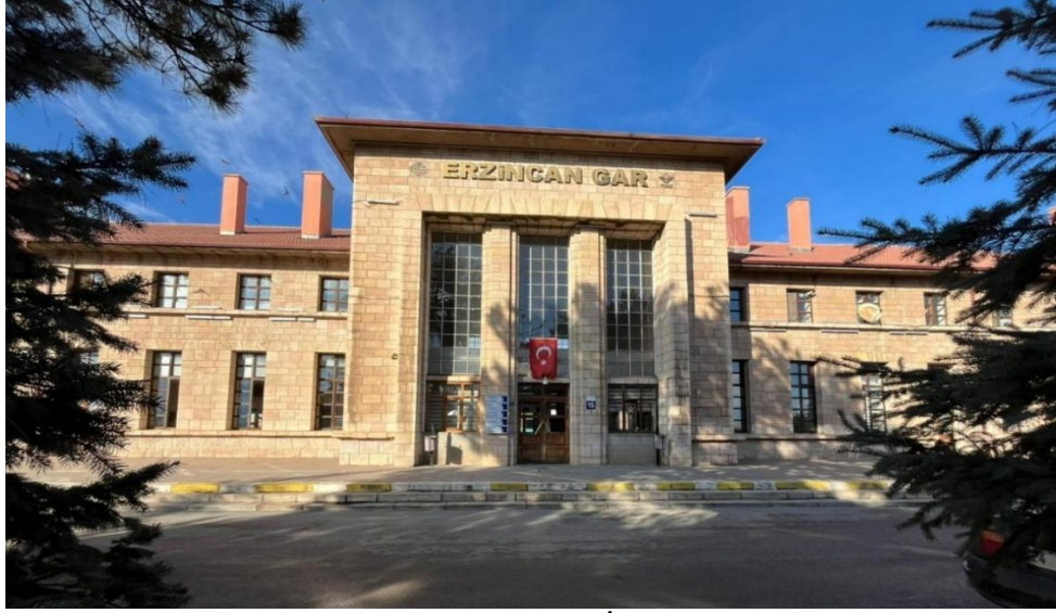
Resim 34. Erzincan Gar Binası genel görünümü (İlknur Keleş)
