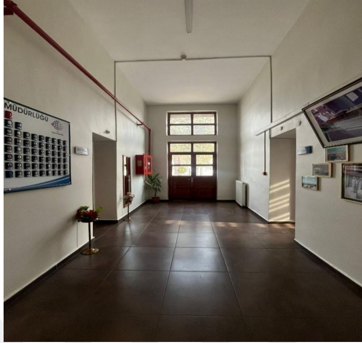
Resim 48. Erzurum Gar Binası doğu kanadında yer alan günümüzden genel görünümü (İlknur Keleş)
