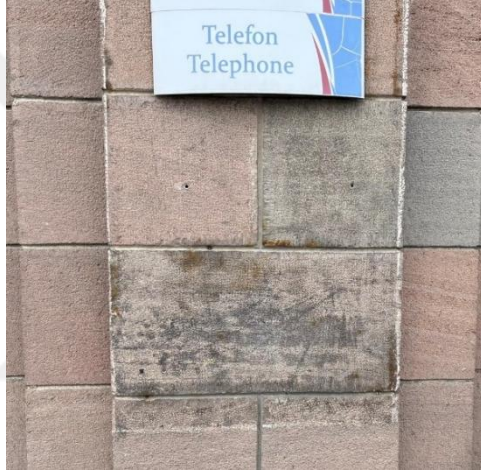
Resim 164. Erzurum Gar Binası cephede oluşan yüzeysel hasarların genel görünümü (İlknur Keleş)
