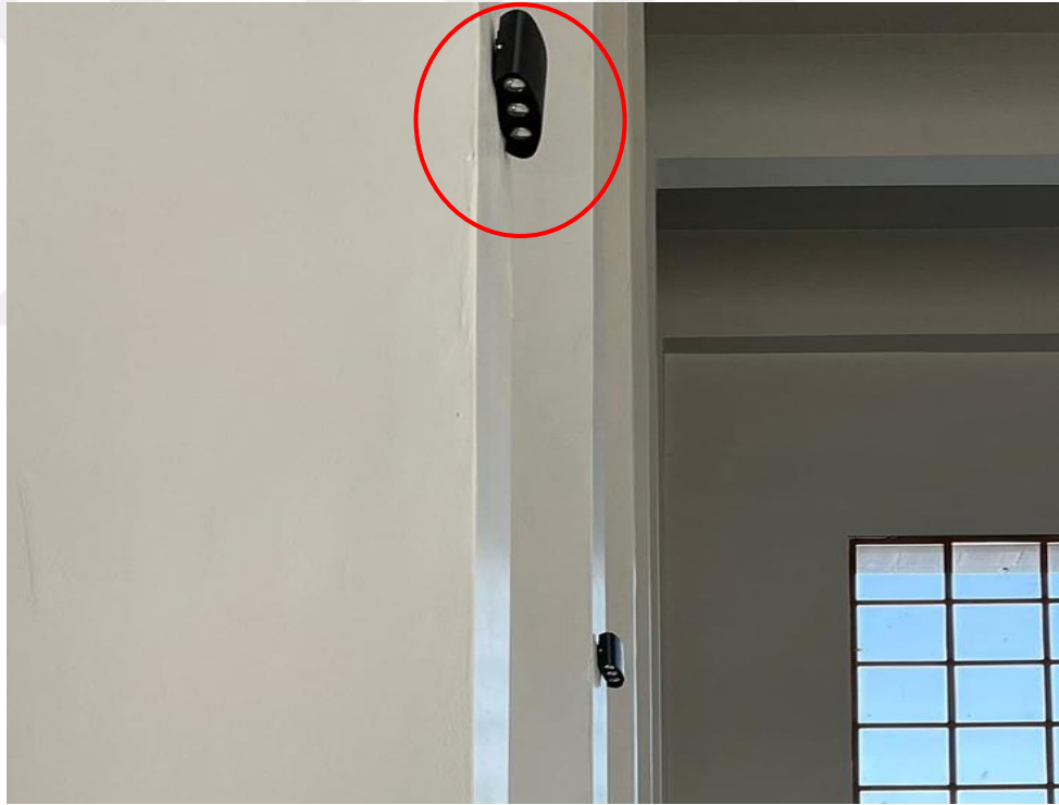
Resim 62. Erzurum Gar Binası bekleme salonu onarım sonrası çift yönlü led aplikten genel görünümü (İlknur Keleş)
