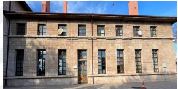
b. Erzincan Gar Binası katları birbirinden ayıran ve cepheyi kuşak halinde çevreleyen silmelerin genel görünümü (İlknur Keleş)
