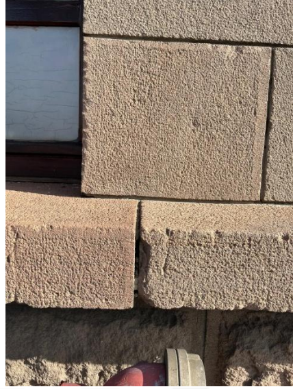
Resim 168. Erzurum Gar Binası derz aralarında oluşan boşlukların genel görünümü (İlknur Keleş)
