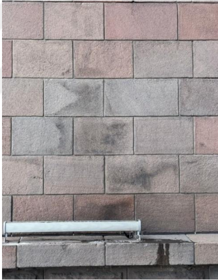
Resim 169. Erzurum Gar Binası cephede oluşan yüzeysel kirlenmenin genel görünümü (İlknur Keleş)
