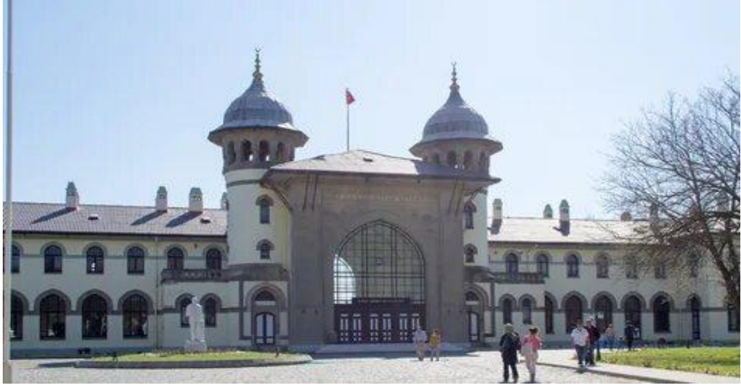
Resim 8. Edirne Gar Binası giriş cephesi genel görünümü (Haştemoğlu, 2012)
