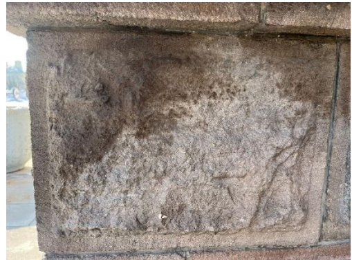
Resim 170. Erzurum Gar Binası cephede oluşan yüzeysel nemlilik genel görünümü (İlknur Keleş)
