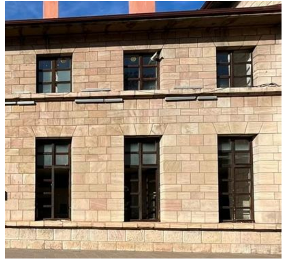
b. Erzincan Gar Binası cephede yer alan farklı boyutlardaki pencere formlarından detay görünümü (İlknur Keleş)
