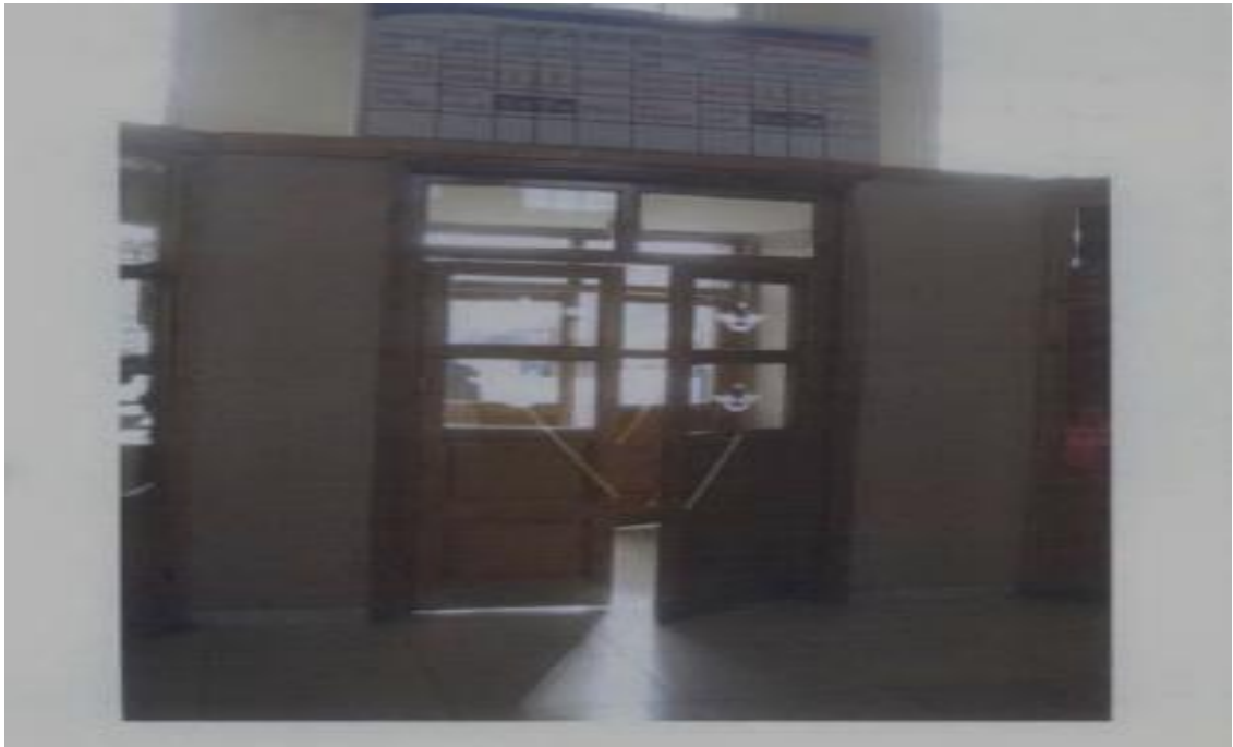
Resim 40. Erzurum Gar Binası ana giriş holünde yer alan rüzgârlıktan genel görünümü (EKVKBK Arşivi)
