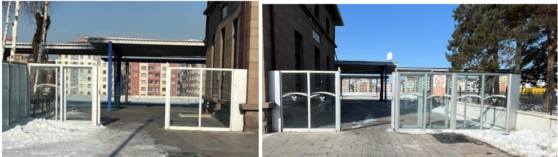
Resim 58. Erzurum Gar Binası sağ ve sol kanatlarda yer alan güvenlik duvarından genel görünümü (İlknur Keleş)
