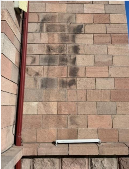
Resim 169. Erzurum Gar Binası cephede oluşan yüzeysel kirlenmenin genel görünümü (İlknur Keleş)
