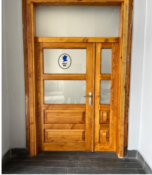
Resim 88. Erzurum Gar Binası erkekler ıslak mekân giriş kapısı (İlknur Keleş)
