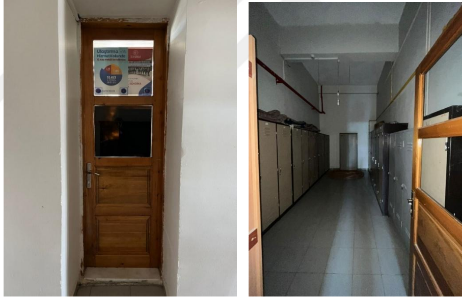
Resim 124. Erzurum Gar Binası batı cephesinde yer alan sendika odası ve personel soyunma odası genel görünümü (İlknur Keleş)
