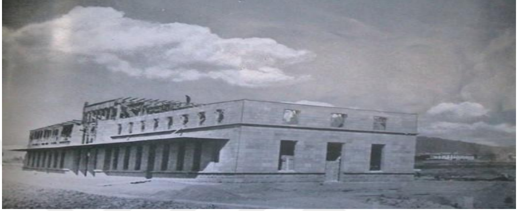
Resim 82. Erzurum Gar Binası inşaa sürecine ait genel görünüm (EKVKBK Arşivi)
