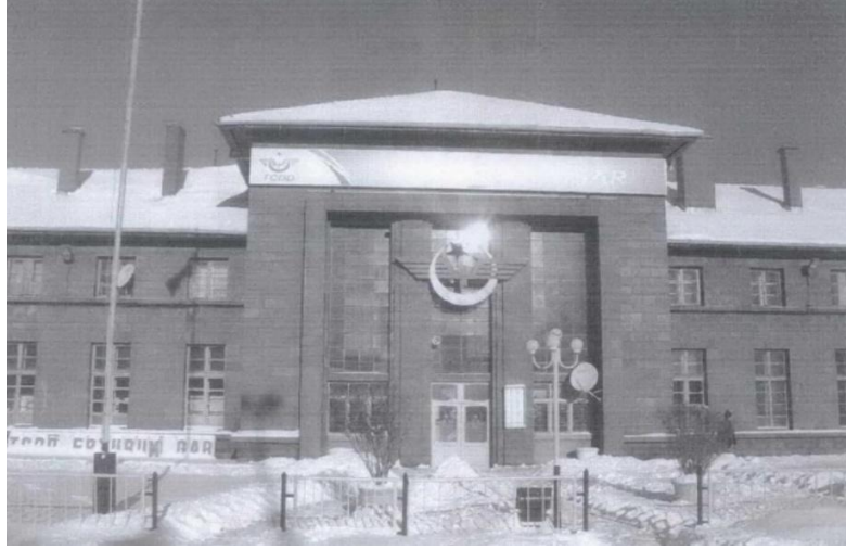
Resim 54. Erzurum Gar Binası 1996 tarihli ahşap doğramalı kapı ve pencerelerden genel görünümü (EKVKBK Arşivi)
