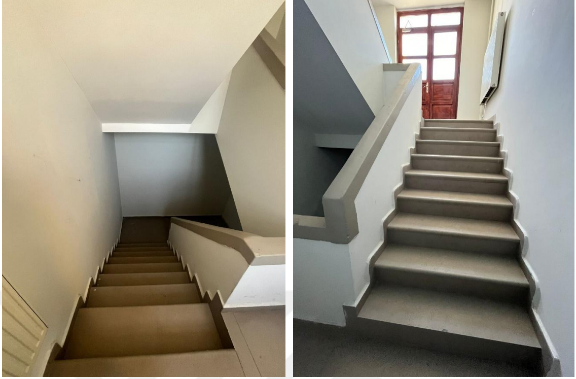
Resim 156. Erzurum Gar Binası batı kanadında yer alan bodrum katına inişi sağlayan merdivenlerin genel görünümü (İlknur Keleş)
