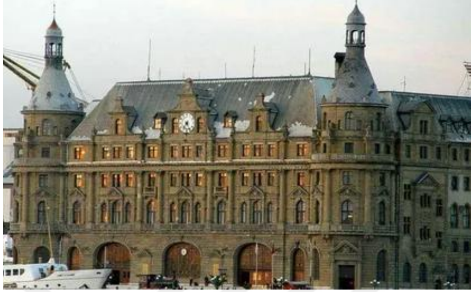
Resim 28. Haydarpaşa Gar Binası genel görünümü (Haştemoğlu, 2012)
