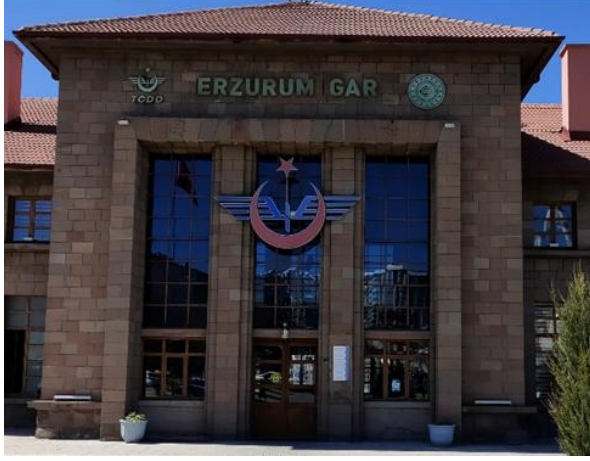
Resim 171 a. Erzurum Gar Binası
