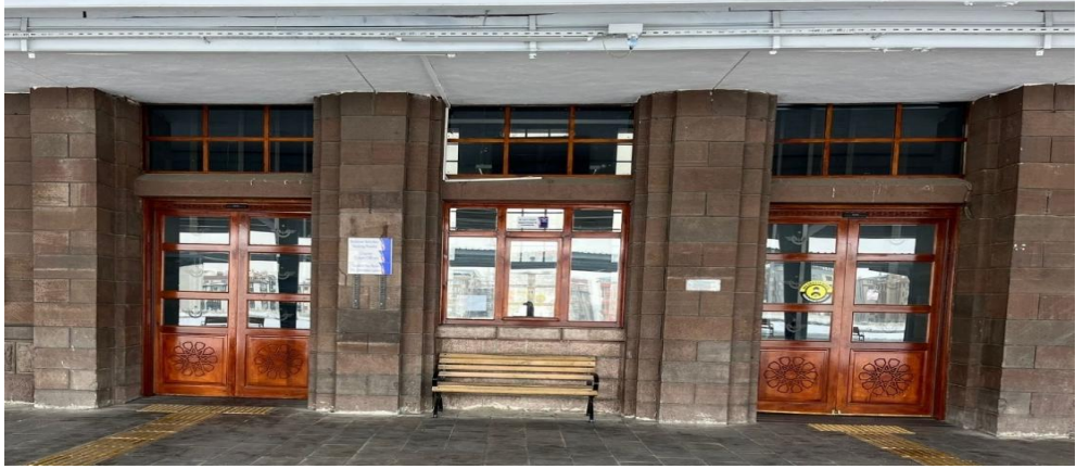
Resim 79. Erzurum Gar Binası kuzey cephede yer alan peron giriş ve çıkış kapılarının genel görünümü (İlknur Keleş)
