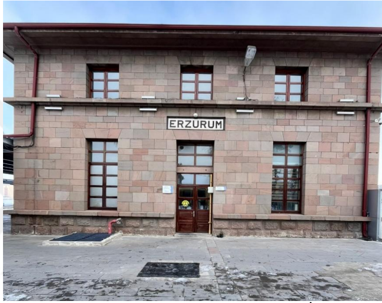
Resim 84. Erzurum Gar Binası batı cephesi genel görünümü (İlknur Keleş)
