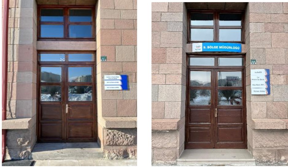
Resim 75. Erzurum Gar Binası ana kütesinin güneybatısında ve güneydoğusunda yer alan birinci kata erişimi sağlayan giriş kapılarından genel görünümü (İlknur Keleş)
