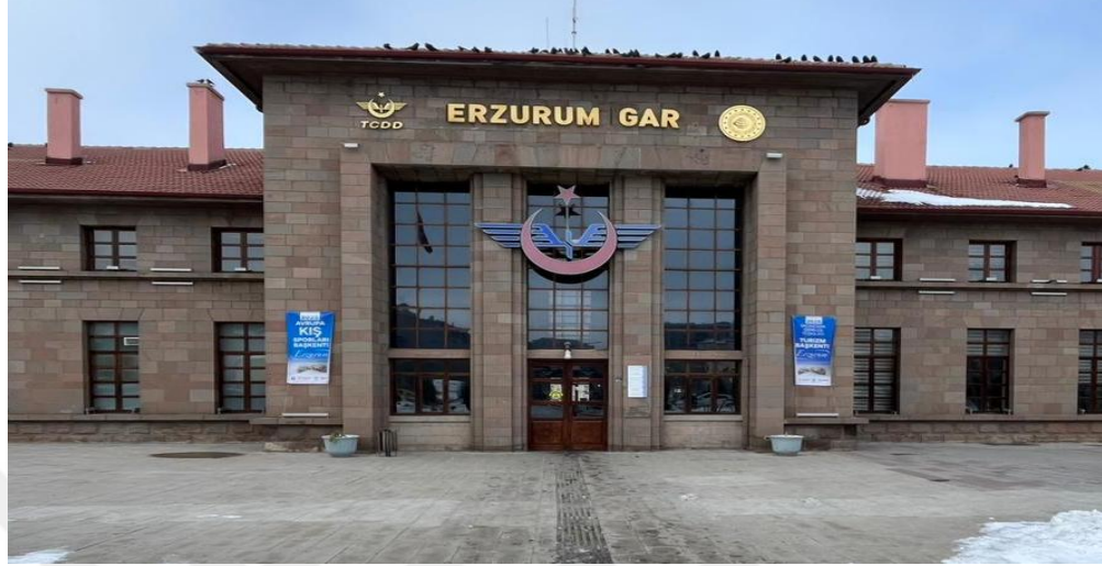
Resim 74. Erzurum Gar Binası güney cephede yer alan dışa taşkın girişin genel görünümü (İlknur Keleş)
