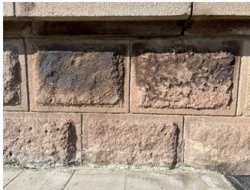
Resim 170. Erzurum Gar Binası cephede oluşan yüzeysel nemlilik genel görünümü (İlknur Keleş)
