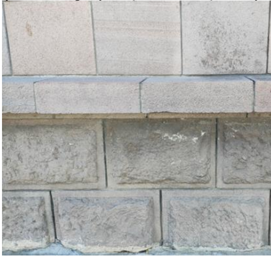
Resim 173 a. Erzurum Gar Binası
