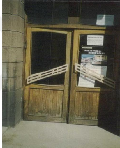
Resim 55. Erzurum Gar Binası ahşap doğramalı çift kanatlı kapıların geçirdiği onarımların genel görünümü (EKVKBK Arşivi)
