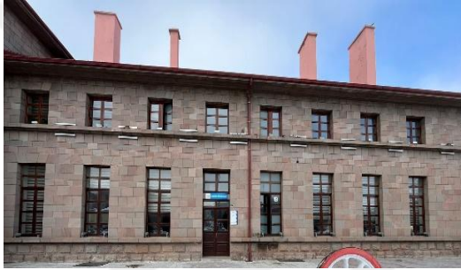
Resim 172 a. Erzurum Gar Binası
