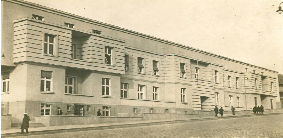
Resim 9. Divan-ı Muhasebat (Sayıştay) Binası genel görünümü (“Sayıştay Binası”, 2023)
