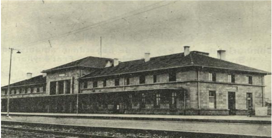
Resim 49. Erzurum Gar Binası kuzey cephede yer alan sundurmadan genel görünümü (Bayındırlık İşleri Dergisi)
