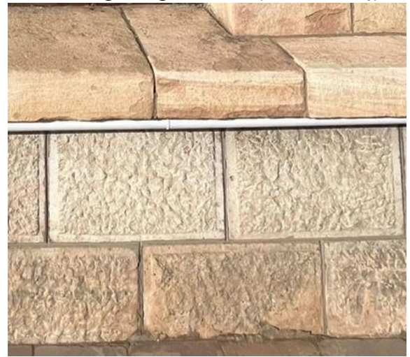
b. Erzincan Gar Binası zemin kat silmelerinin alt hizasında kullanılan bosaj duvar örgüsü detay görünümü (İlknur Keleş)
