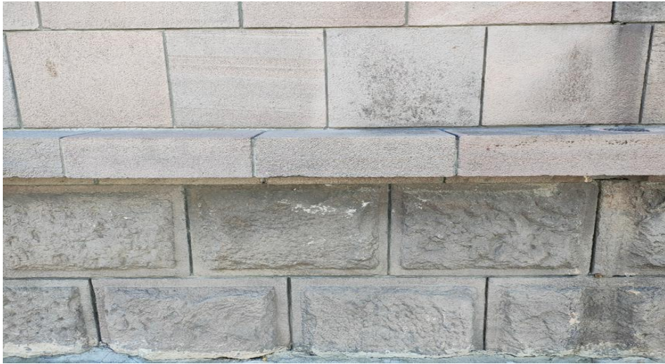
Resim 71. Erzurum Gar Binası yapı eteğindeki bosaj duvar örgüsünden detay görünümü (İlknur Keleş)
