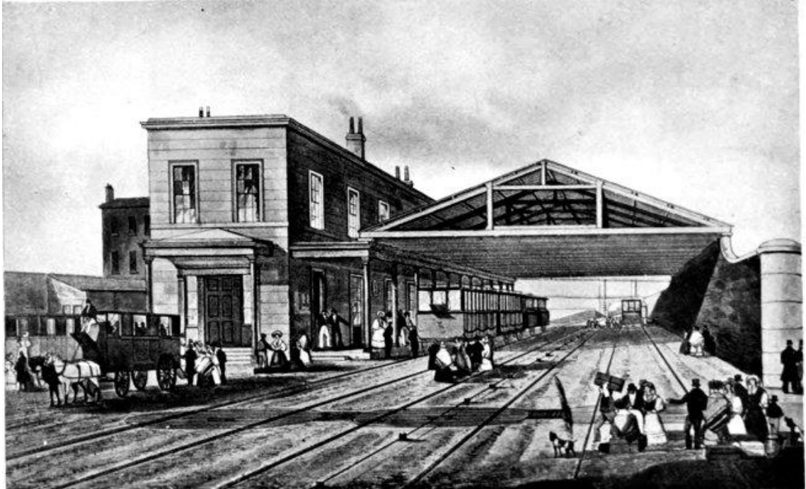
Resim 15. Crown Street İstasyon Binası (1830) genel görünümü (Url 15)
