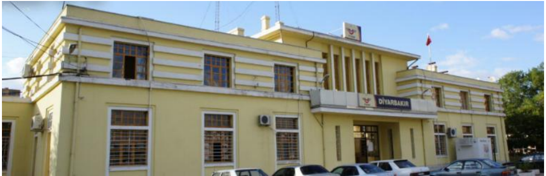
Resim 34. Diyarbakır Gar Binası genel görünümü ("Diyarbakır Garı", 2024)
