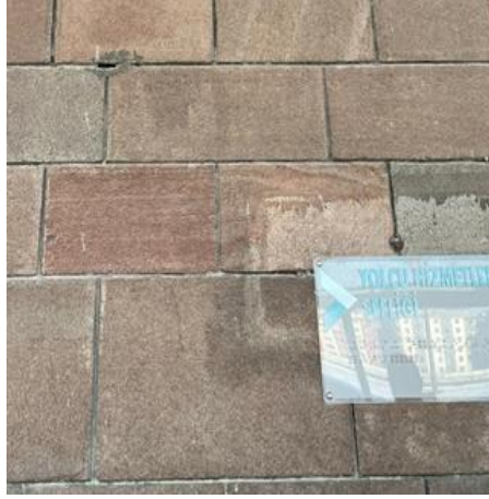
Resim 163. Erzurum Gar Binası cephede oluşan yüzeysel hasarların genel görünümü (İlknur Keleş)
