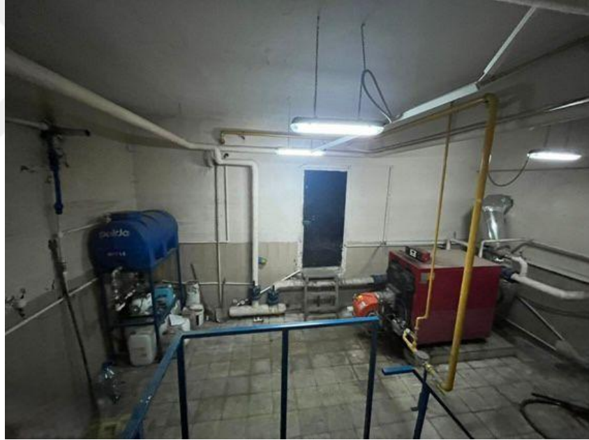
Resim 162. Erzurum Gar Binası güney cephesinin batı kanadında yer alan bodrum katı genel görünümü (İlknur Keleş)
