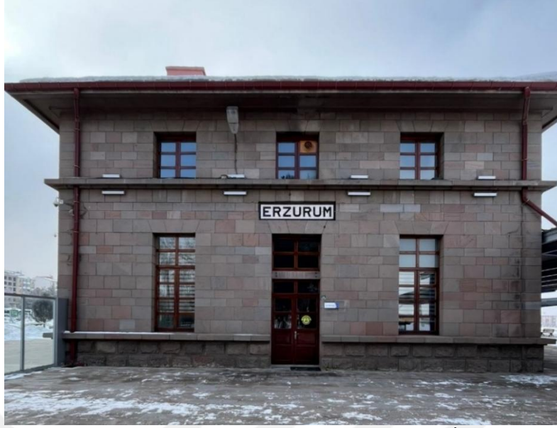
Resim 77. Erzurum Gar Binası doğu cephesi genel görünümü (İlknur Keleş)
