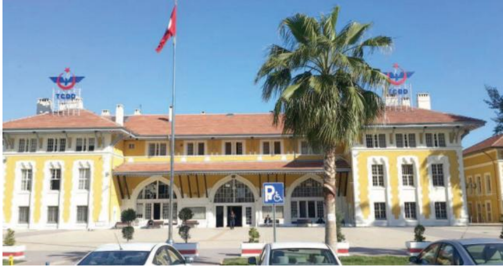
Resim 30. Adana Gar Binası genel görünümü (Durukan Kopuz, 2016)
