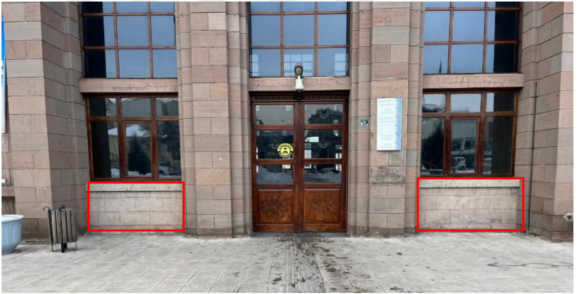
Resim 53. Erzurum Gar Binası güney cephede yer alan kapı açıklıklarının pencereye dönüşümünden genel görünümü (İlknur Keleş)
