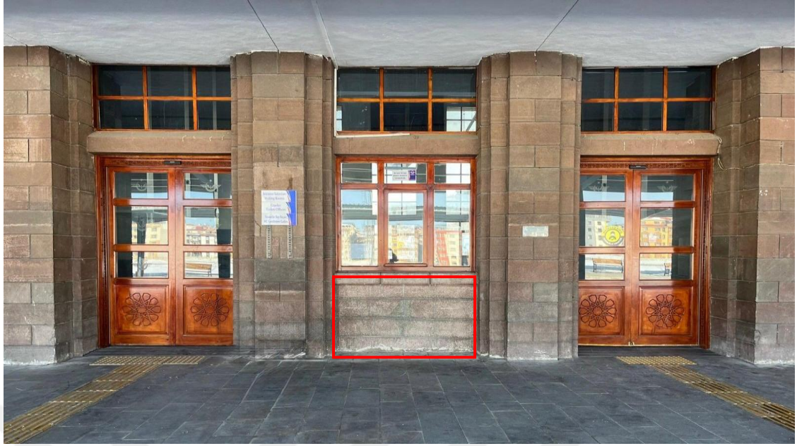
Resim 52. Erzurum Gar Binası kuzey cephede yer alan kapı açıklığının pencereye dönüşümünden genel görünümü (İlknur Keleş)
