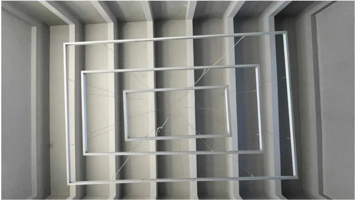
Resim 60. Erzurum Gar Binası bekleme salonu onarım sonrası Lineer sarkıt led aydınlatmanın genel görünümü (İlknur Keleş)
