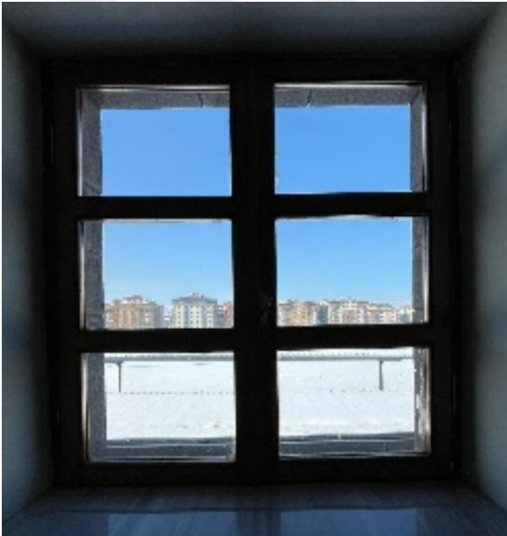
Resim 175 a. Erzurum Gar Binası
