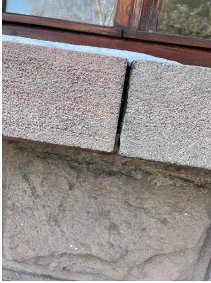
Resim 168. Erzurum Gar Binası derz aralarında oluşan boşlukların genel görünümü (İlknur Keleş)
