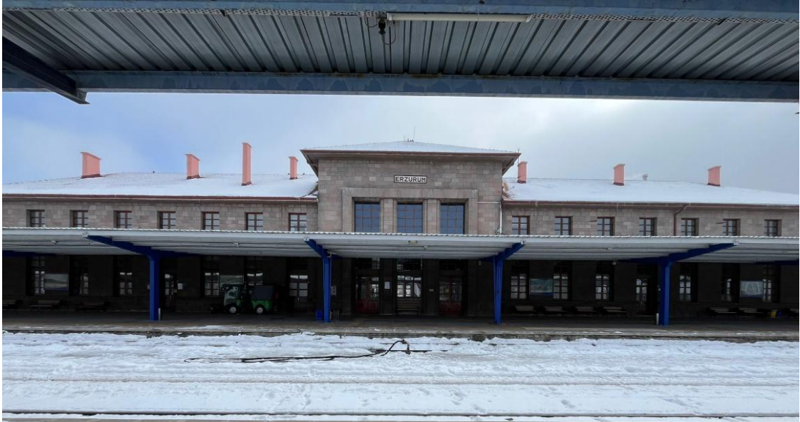
Resim 51. Erzurum Gar Binası kuzey cephede yer alan markiz örtü, günümüzden genel görünümü (İlknur Keleş)
