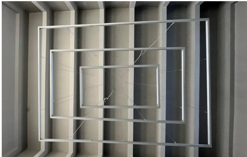
Resim 96. Erzurum Gar Binası tavandaki kolon kiriş uygulaması detay görünümü (İlknur Keleş)
