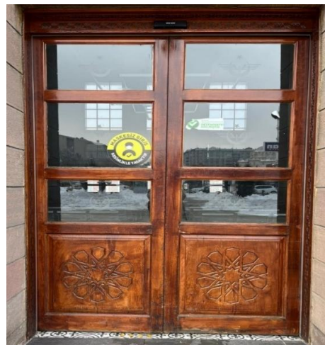
Resim 56. Erzurum Gar Binası ahşap doğramalı çift kanatlı kapının günümüz kullanımından genel görünümü (İlknur Keleş)
