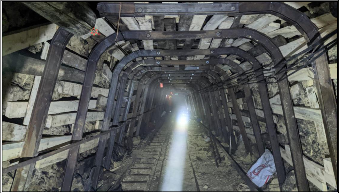
Şekil 4.3. Nefeslik desandresinde tahkimatların NPI-100 demir tahkimata dönüşümü
