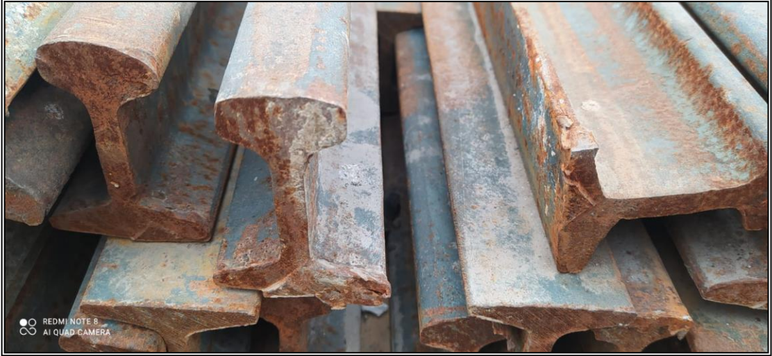
Şekil 4.11. Ocak'ta kullanılmakta olan 10 kg/m ray demiri kesit görüntüsü
