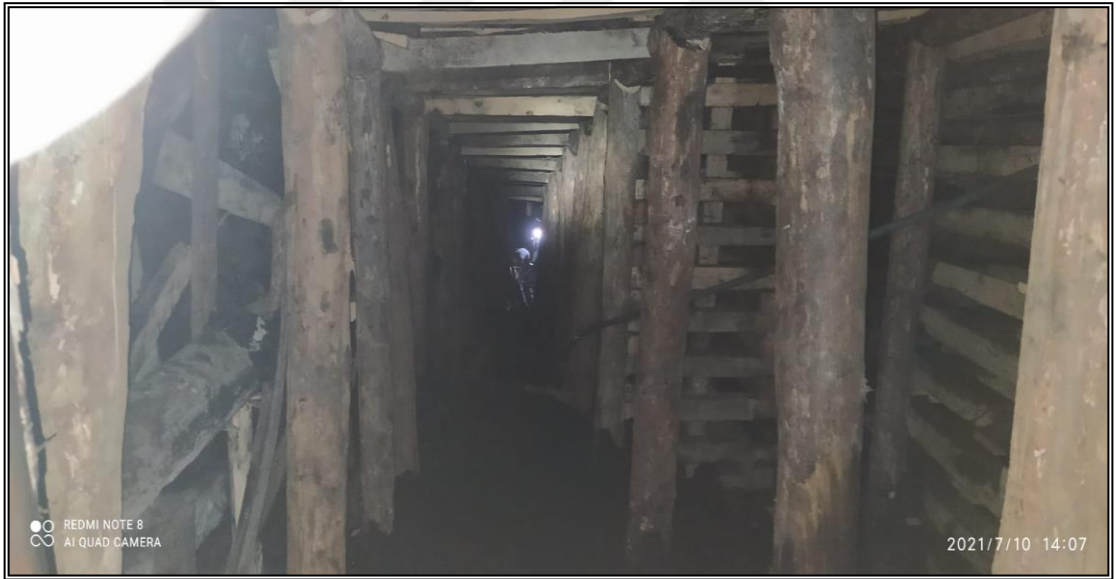
Şekil 4.8. Mevcut pano üretim ayağında arına paralel sarma tahkimatlı enine kesit görünüm
