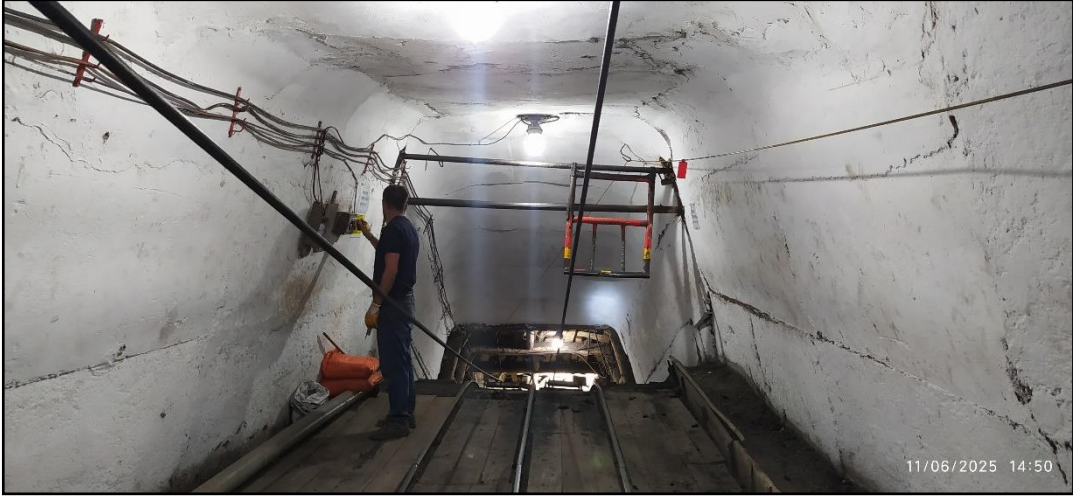
Şekil 4.44. Mekanize sistem ana nakliyat desandresinde raylı sistem vagon varagel nakliyat fotoğrafı
