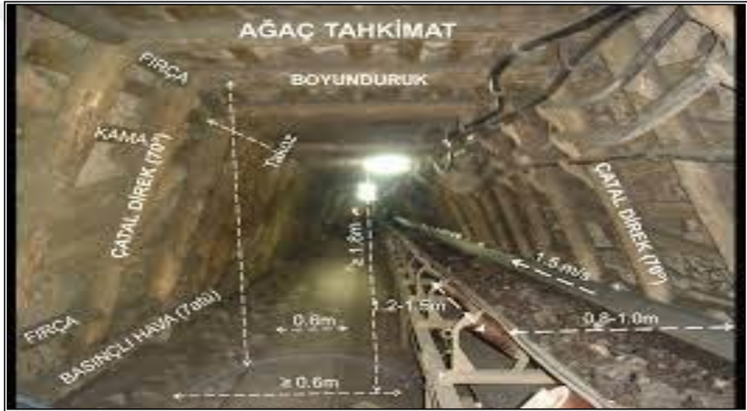
Şekil 4.1. Yeraltında galeri ve desandrelerde mevcut tahkimat şekli ve elemanları (Su, O., 2011)
