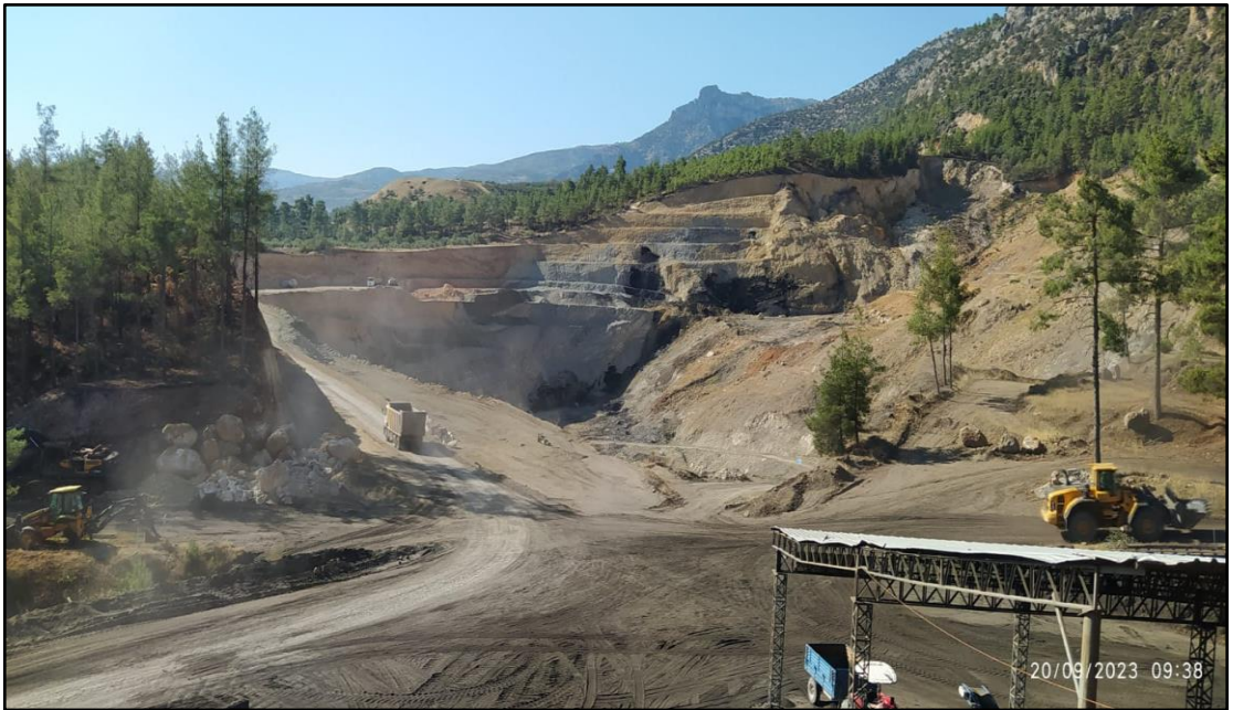
Şekil 3.37. Çanakçı kömür işletmesi 1-nolu açık ocağı kuzey ucundan genel görünümü
