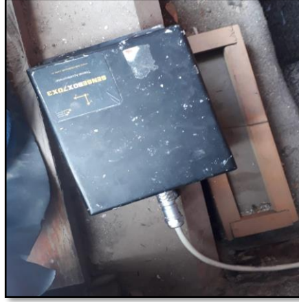
Şekil 4.81. Yeğenağa Camii minaresi ivmeölçer sabitleme işlemi
