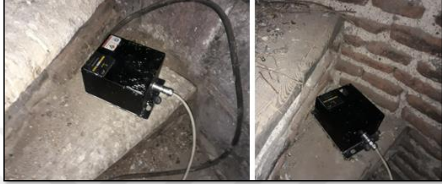
Şekil 4.93. Kadana Camii minaresi ivmeölçer sabitleme işlemi
