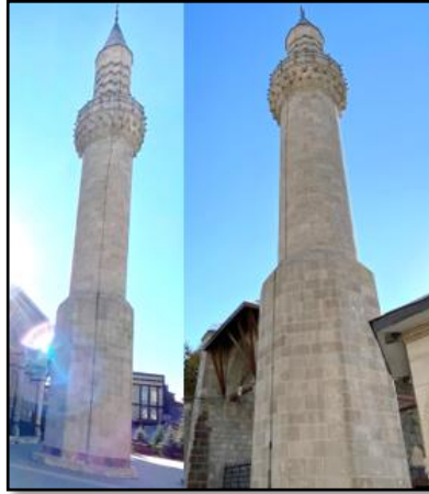
Şekil 3.23. Murat Paşa Camii Minaresi
