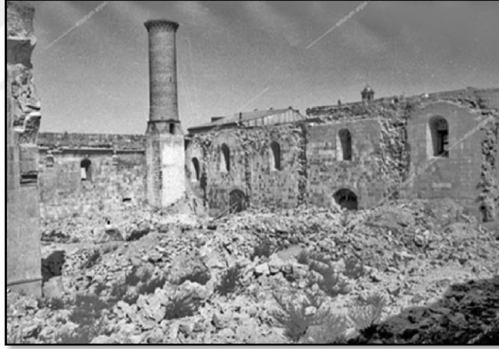
Şekil 3.20. Ulu Camii restorasyonu (Anonim 2025m)
