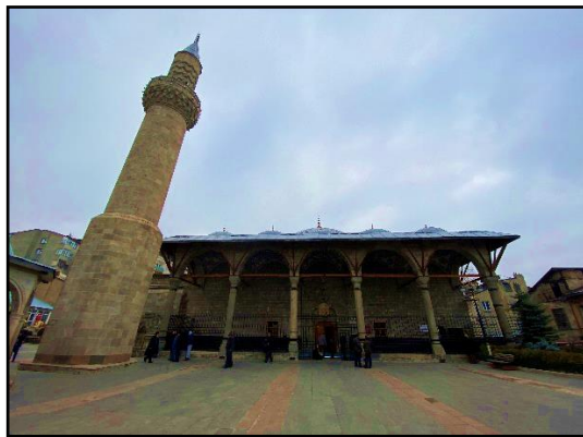
Şekil 3.22. Muratpaşa Camii genel görünümü
