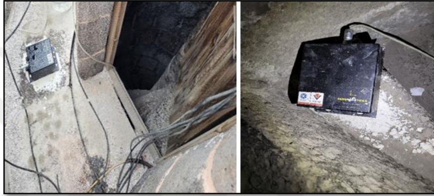
Şekil 4.7. Pervizoğlu Camii minaresi ivmeölçer sabitleme işlemi
