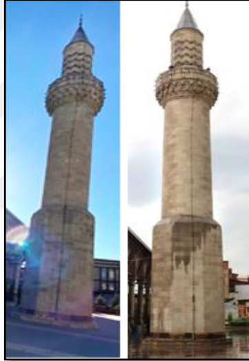
Şekil 4.40. Murat Paşa Camii minaresi
