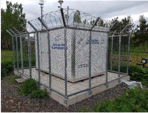
c) TCDD istasyon dış görünüş
