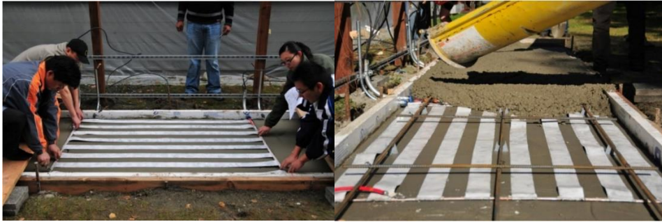
Görsel 11: Karbon Fiber Bantların Zemin İçerisine Yerleştirilmesi ve Betonla Kaplanması İşlemi
