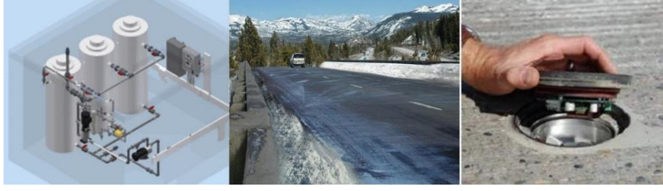
Görsel 4: Otomatik Solüsyon Püskürtme Sistemi
