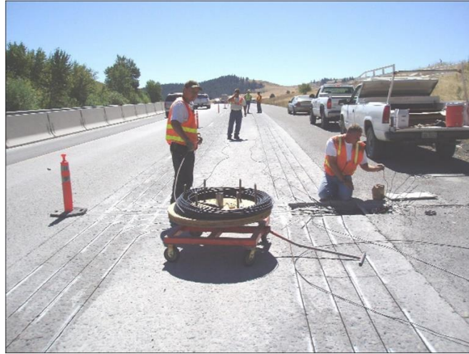
Görsel 16: Elektriksel İletken Isıtma Kablolarının Teker İzleri Boyunca Kaplama Zeminine Yerleştirilmesi
