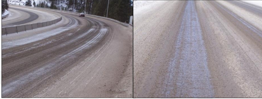
Görsel 17: İletken Isıtma Kablo Sisteminin Uygulama Sonrasındaki Kar ve Buzu Eritmesi İşlemi
