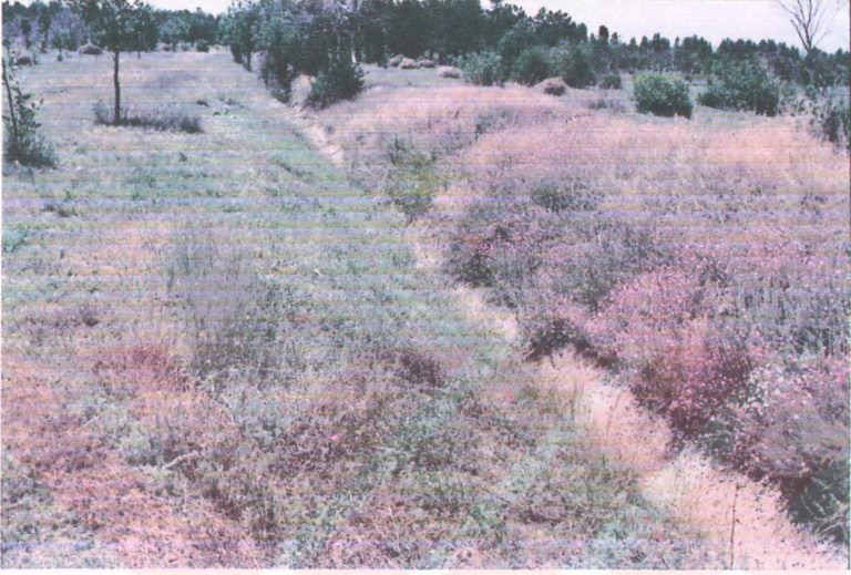
Şekil 4.15. Alan içindeki mevcut ana sulama kanalı
