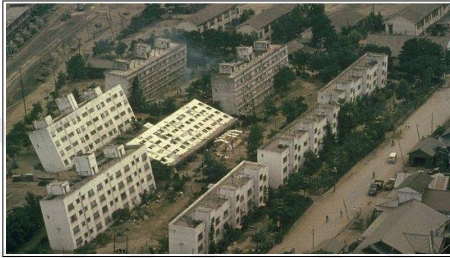
Şekil 2.11 Niigata 1964 depremi sıvılaşmaya uğramış zeminin yapılar üzerindeki etkisi
