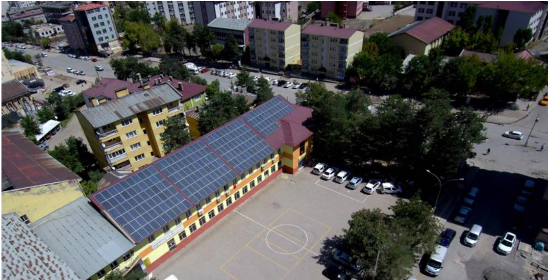
Ek – 16 Muş'taki okullarda güneş enerjisiyle elektrik üretimi (AA, 2018)
