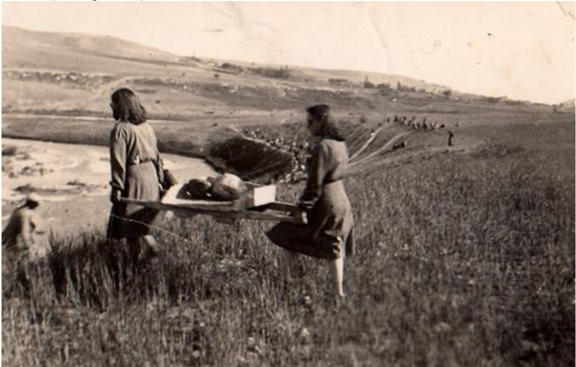
Ek – 2 Akçadağ Köy Enstitüsü kız öğrencileri, elektrik santrali inşaatında (E-skop, 2021).
