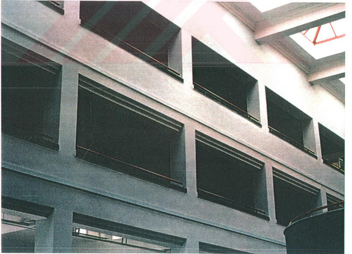
Resim 10- Panonun Uygulandığı D.E.Ü.Tıp Fakültesi Yeni Derslikler Binası İç Görünümü
