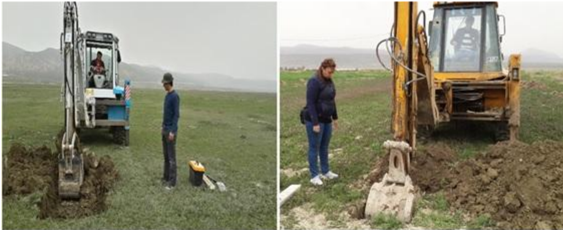
Şekil 3.5. Profil çukurlarının iş makinesi ile açılması
