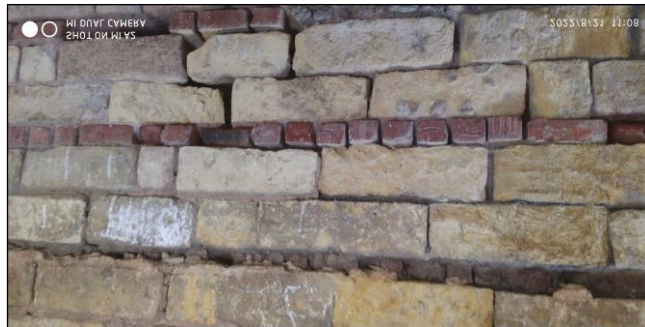
Resim 4.9.5. Konutun Almasıık Taş Duvarı (Yazar, 2025).
