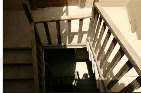
Resim 5.8. Zeynep Hatun Konutu Ahşap Merdiveni
