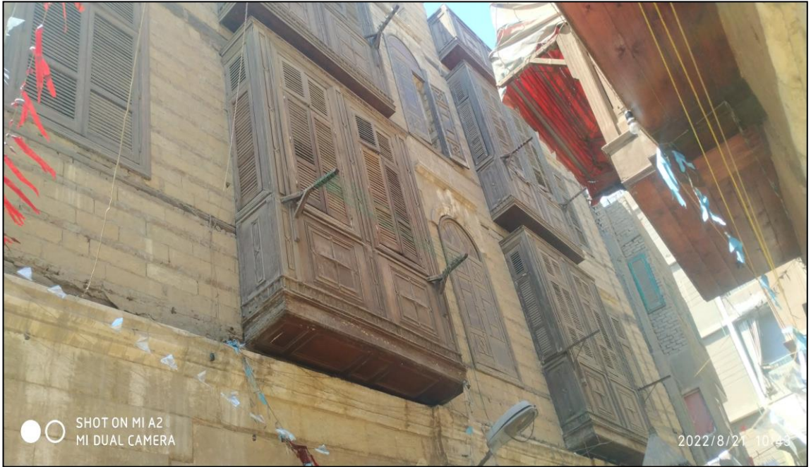
Resim 4.1.6. Konutun Kuzey Cephesi Maşrabiyyesi (Yazar, 2025)
