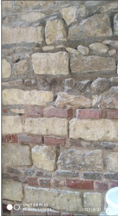
Resim 4.9.3. Konutun Almasıık Taş Duvarı (Yazar,2025).
