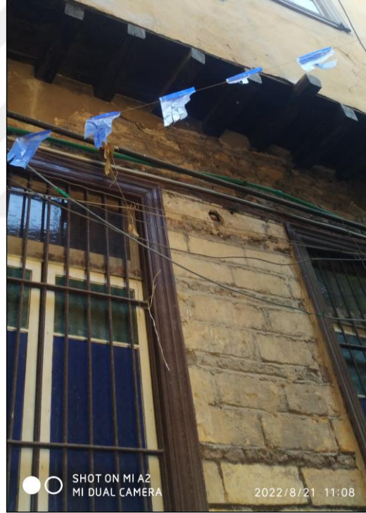
Resim 4.9.4. Konutun Almasıık Taş Duvarı (Yazar, 2025).
