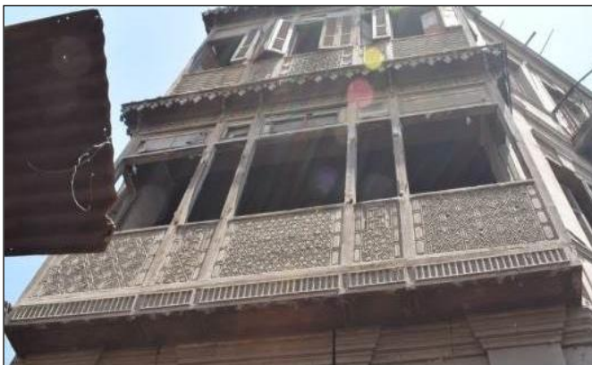
Resim 4.3.2. Al-Qirabi Konut Cephinin Maşrabiyyesi (Elnahhal 2019). Şekil 4.3.5. Maşrabiyyenin Detayı (Elnahhal 2019).
