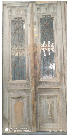
Resim 4.8.2. Al-Mahgar Konutu Giriş Kapısı (Yazar, 2025).
