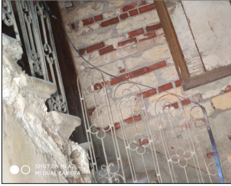
Resim 5.5. Abuulhasan Konutu Merdiveni
