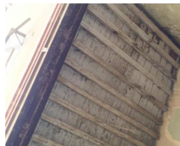
Şekil 4.5.8. Duvar Detayı ve Tavanın Ahşap Kirişleri
