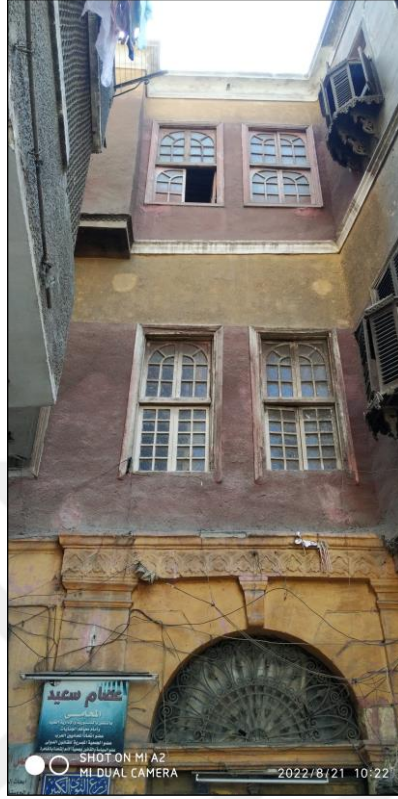
Resim 4.2.4. Zarılava Konutu Giriş Cephesi (Yazar, 2025).
