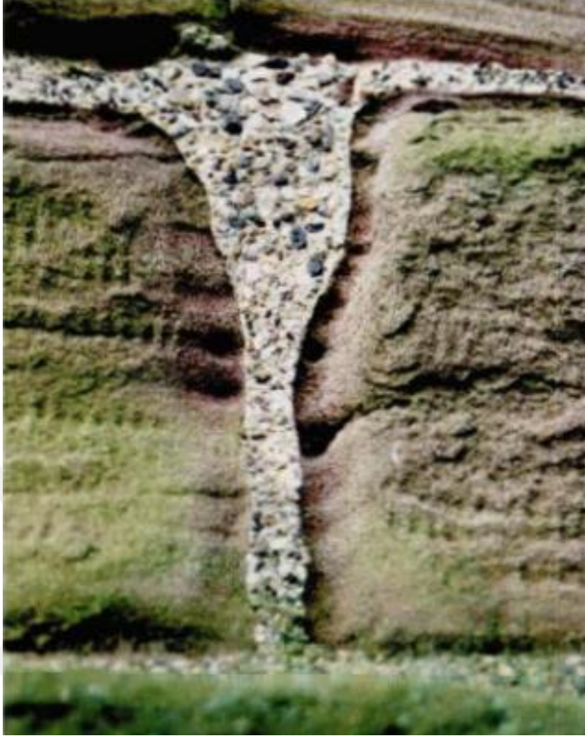
Şekil 1.2: Sert harç, harçtan ziyade kumtaşı içinde nem tutulmasını kolaylaştırır.
