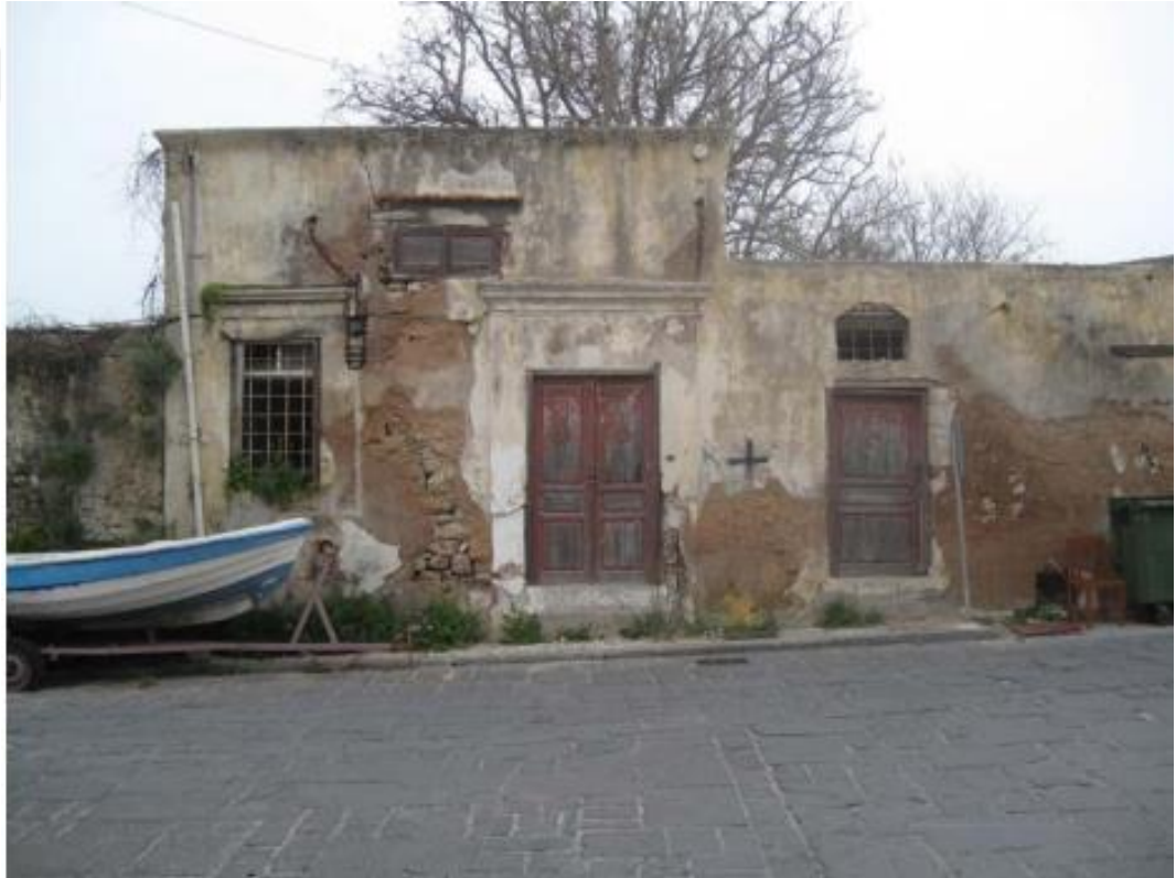
Şekil 1.4: Sert harç, harçtan ziyade kumtaşı içinde nem tutulması. Orta Çağ'dan kalma Rodos Şehri'nden bir örnek.
