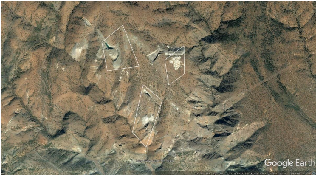
Şekil 7. Beyazaltın Projesi Maden Sahası’nın 2002 yılında çekilmiş uydu fotoğrafındaki durumu
