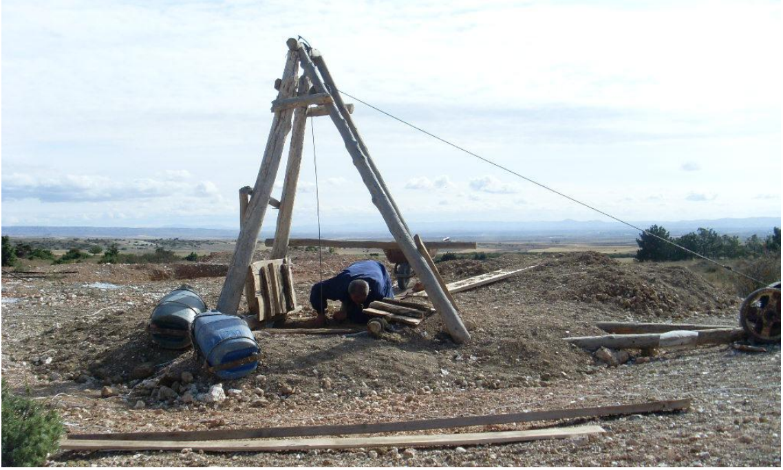
Şekil 11: Lületaşı kuyusuna skip yöntemiyle giriş
