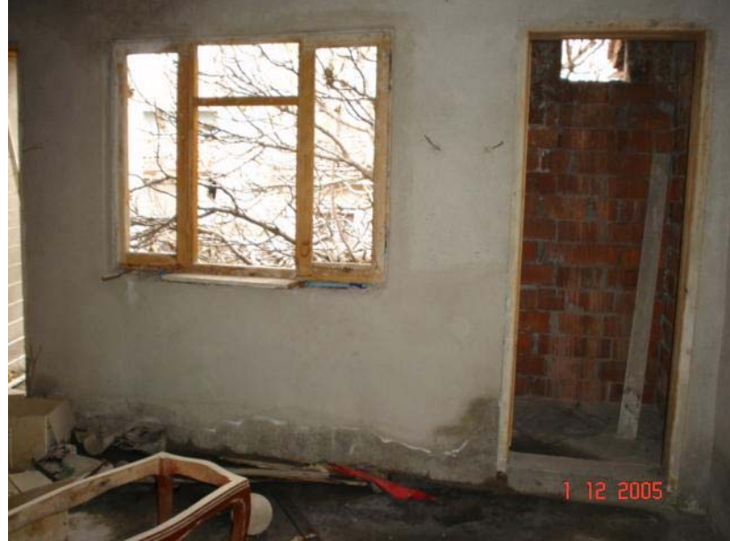
Resim 4.54. 103 mekânı 4 nolu duvar görünüşü
