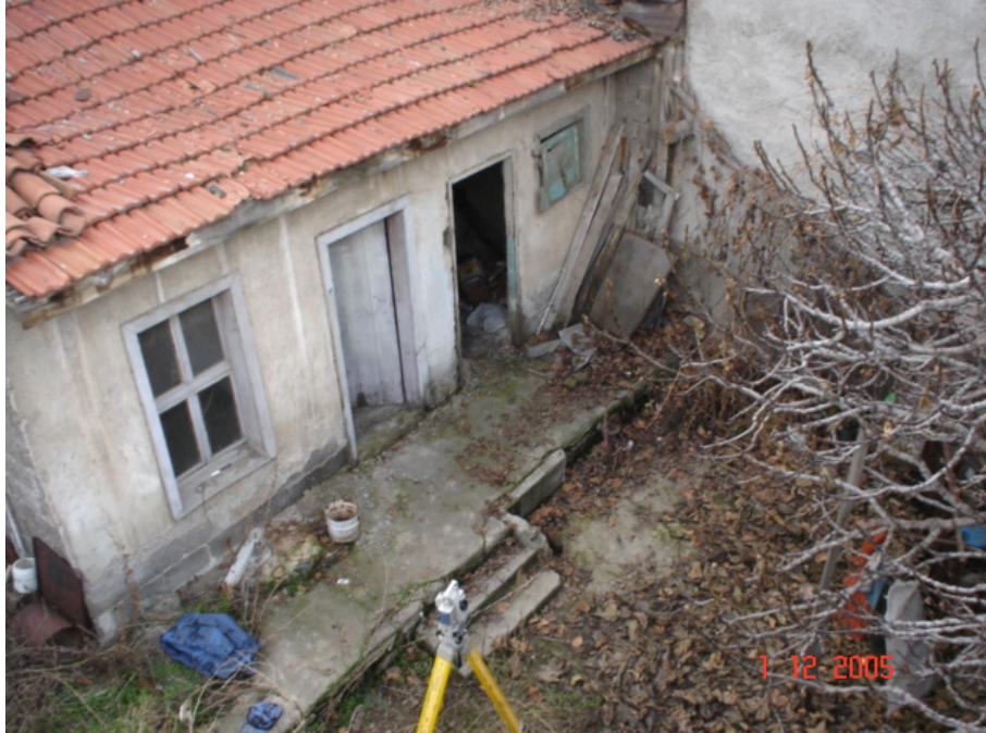
Resim 4.6. Bahçe depo binası
