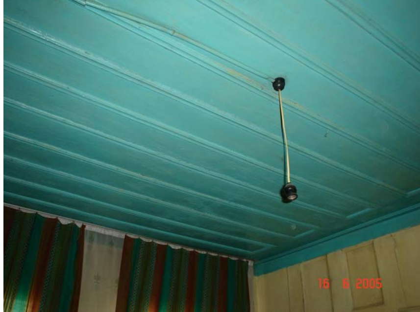
Resim 4.68. 102 oda mekânı tavan görünüşü
