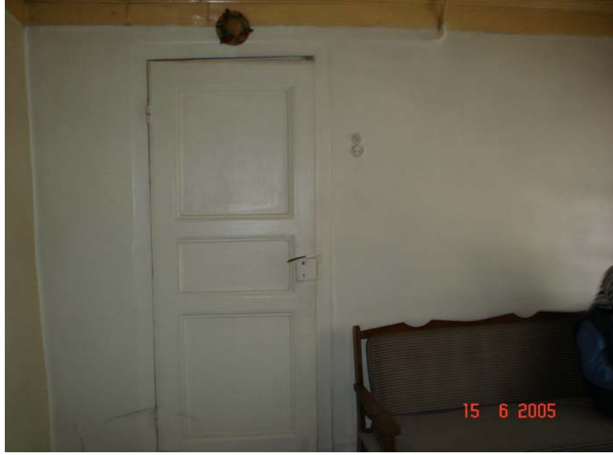
Resim 4.15. ZO2 mekân 1 nolu duvar görünüşü
