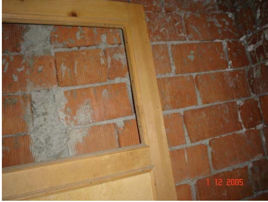
Resim 4.57. 104 mekânı 3 nolu duvar görünüşü
