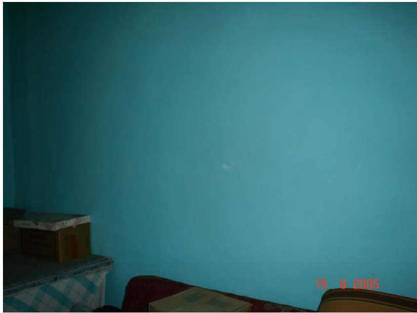
Resim 4.62. 105 mekânı 4 nolu duvar görünüşü
