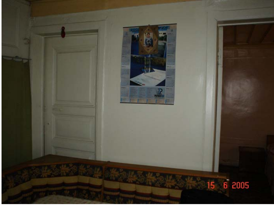
Resim 4.9. ZO1 mekanı 1 nolu duvar görünüşü
