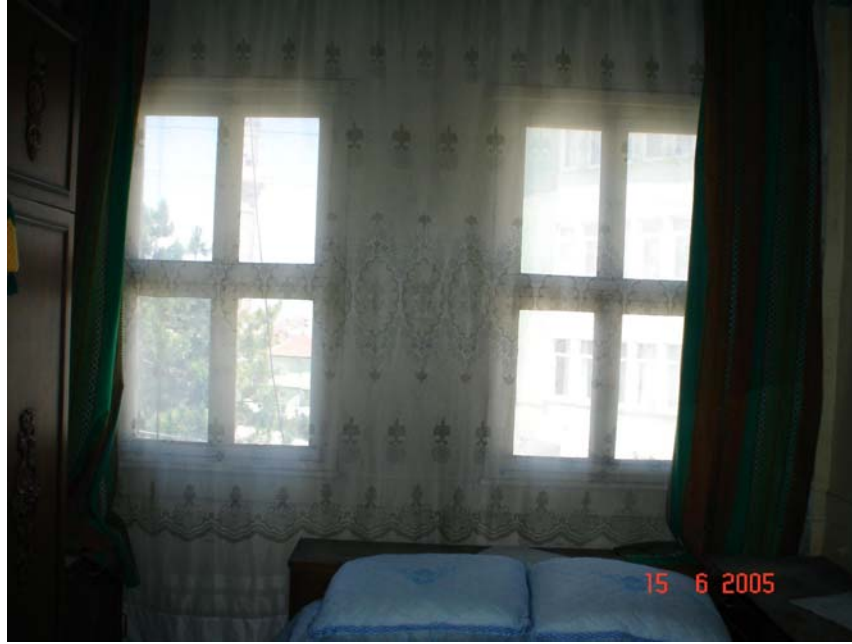
Resim 4.47. 102 mekânı 2 nolu duvar görünüşü
