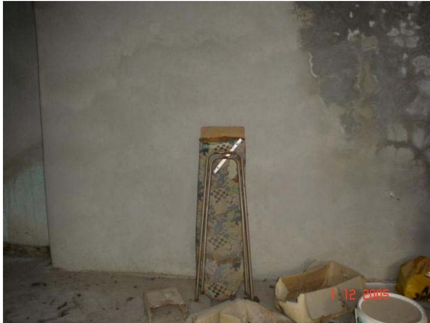
Resim 4.52. 103 mekânı 2 nolu duvar görünüşü
