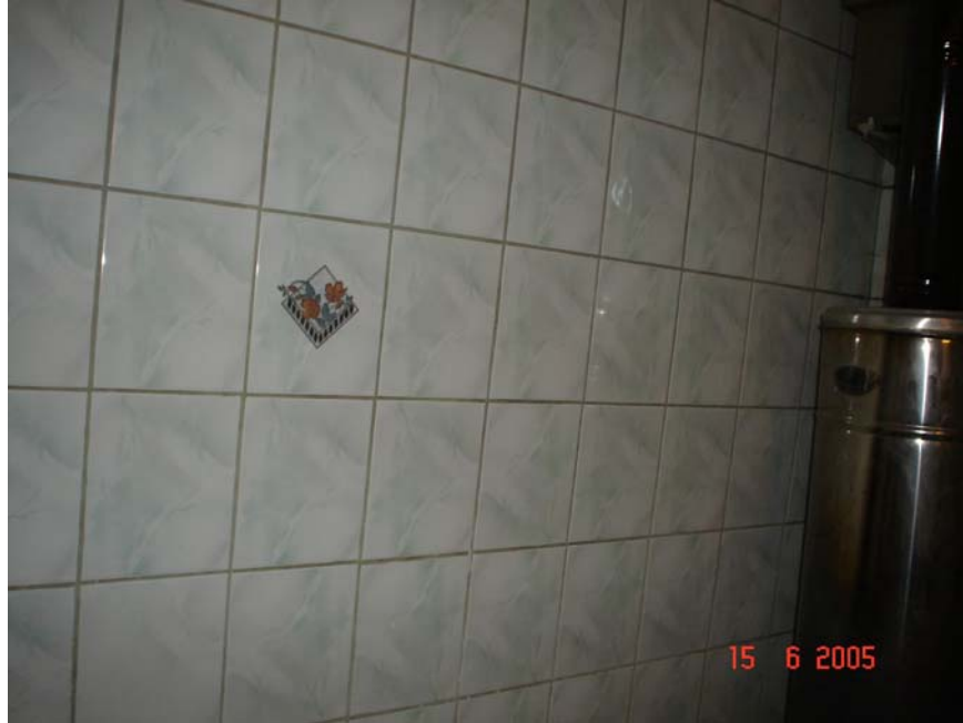
Resim 4.20. ZO3 mekanı 2 nolu duvar görünüşü
