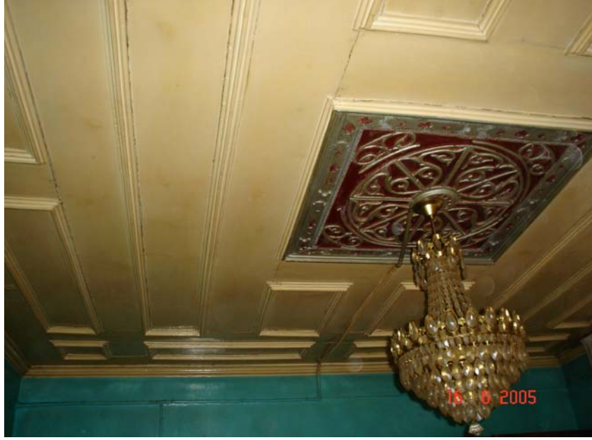
Resim 4.69. 106 oda mekânı tavan görünüşü
