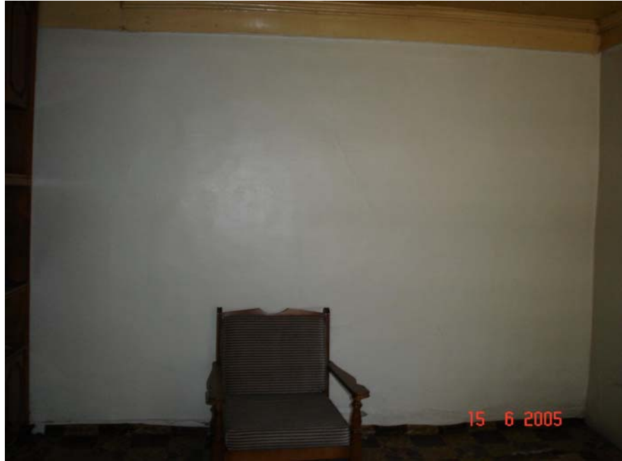
Resim 4.18. ZO2 mekân 4 nolu duvar görünüşü
