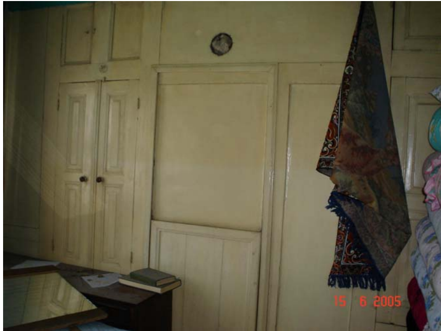
Resim 4.48. 102 mekânı 3 nolu duvar görünüşü
