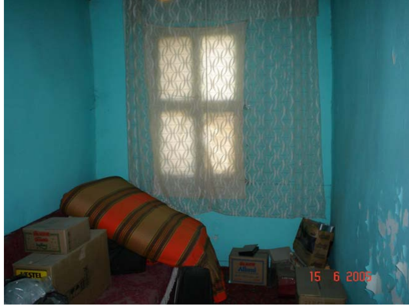
Resim 4.59. 105 mekânı 1 nolu duvar görünüşü
