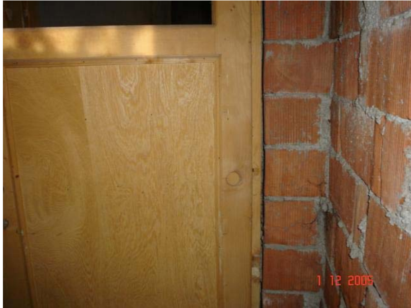
Resim 4.56. 104 mekânı 2 nolu duvar görünüşü
