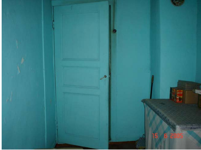
Resim 4.61. 105 mekânı 4 nolu duvar görünüşü
