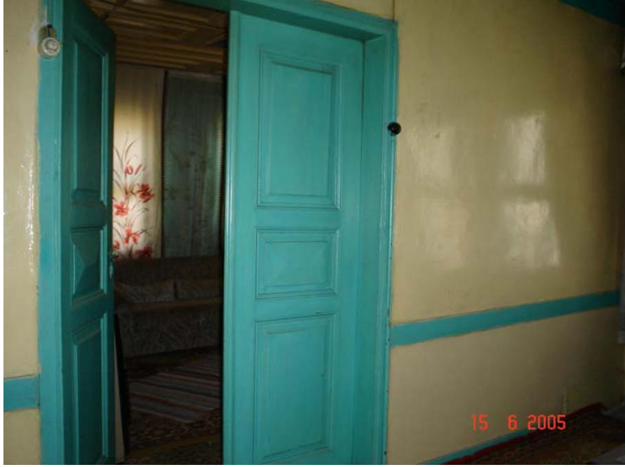
Resim 4.41. 101 mekânı 1 nolu duvar görünüşü
