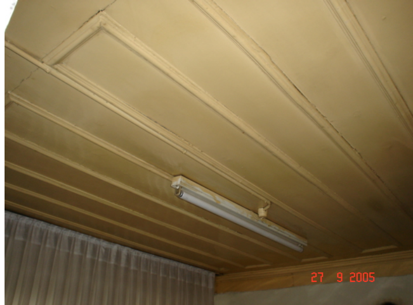
Resim 4.70. ZO2 oda mekânı tavan görünüşü
