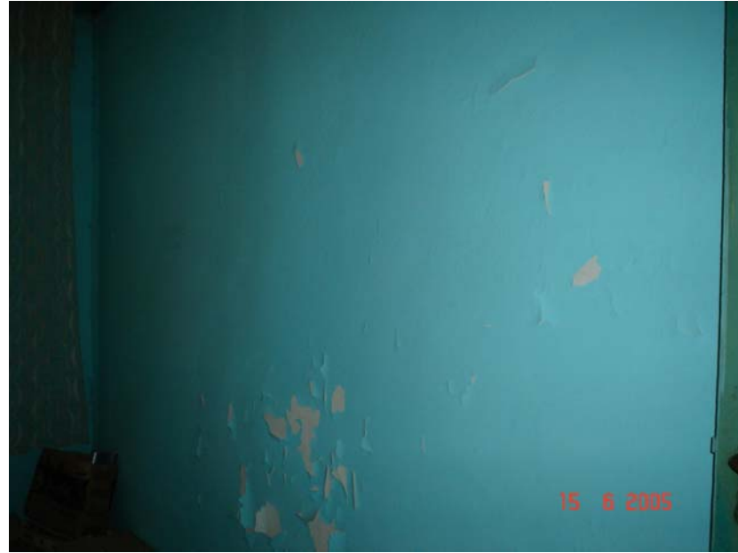
Resim 4.60. 105 mekânı 2 nolu duvar görünüşü
