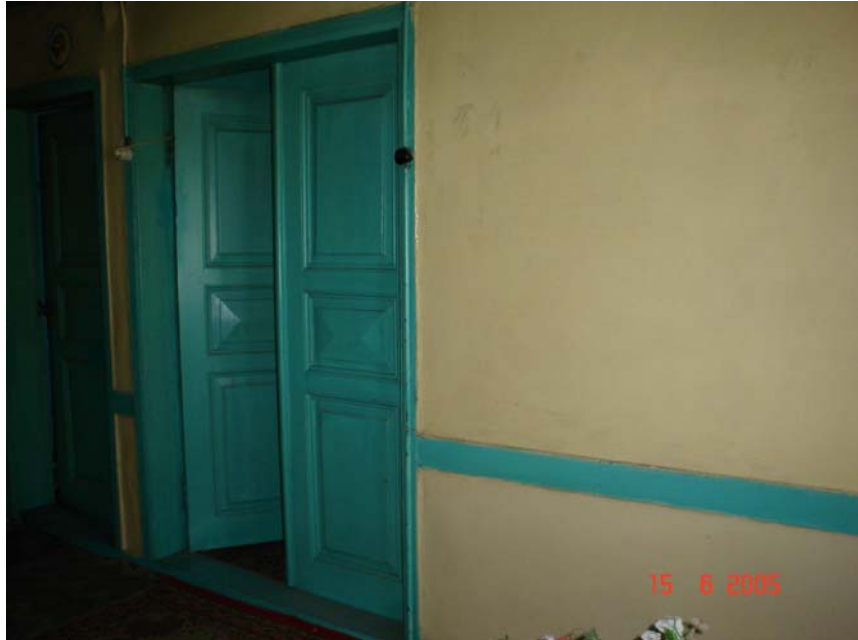
Resim 4.40. 101 mekânı 1 nolu duvar görünüşü
