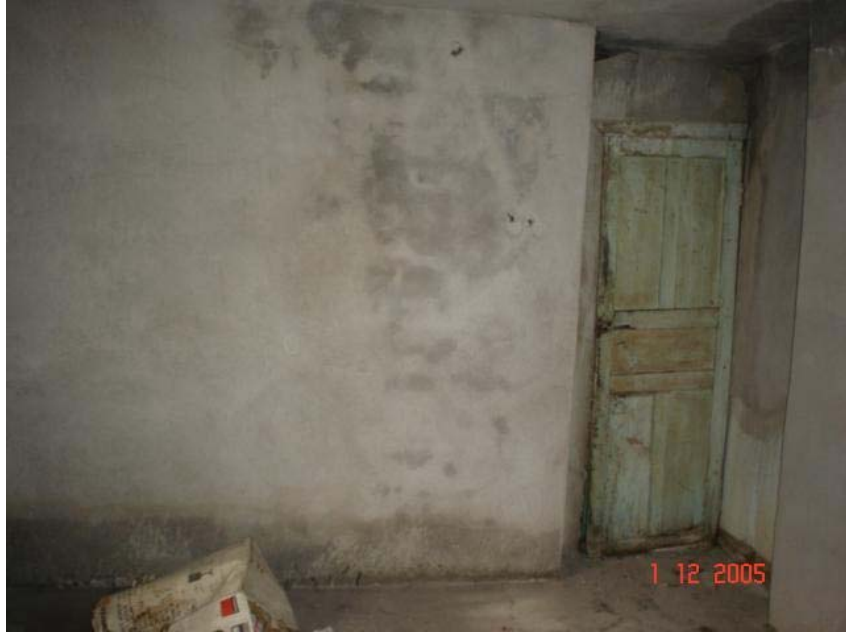
Resim 4.51. 103 mekânı 1 nolu duvar görünüşü
