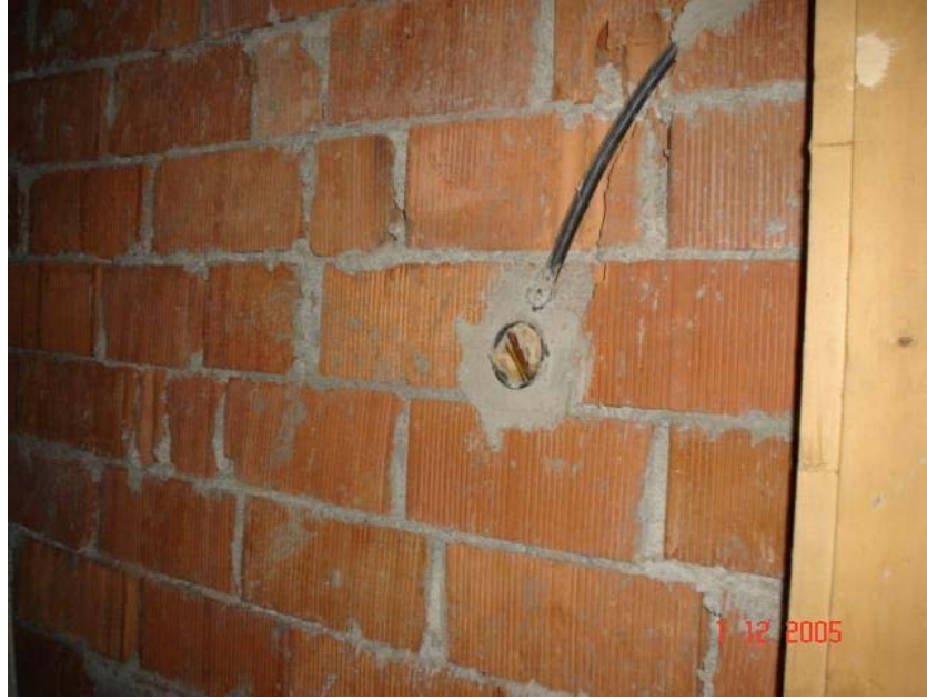
Resim 4.55. 104 mekânı 1 nolu duvar görünüşü
