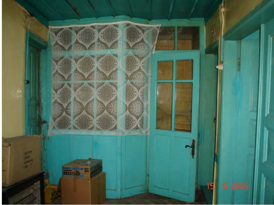
Resim 4.45. 101 mekânı 4 nolu duvar görünüşü
