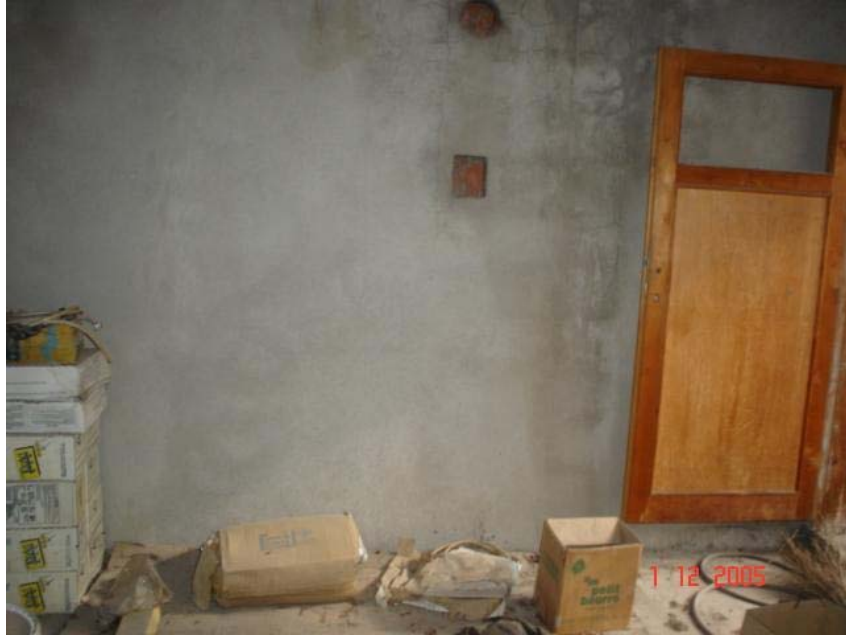
Resim 4.53. 103 mekânı 3 nolu duvar görünüşü
