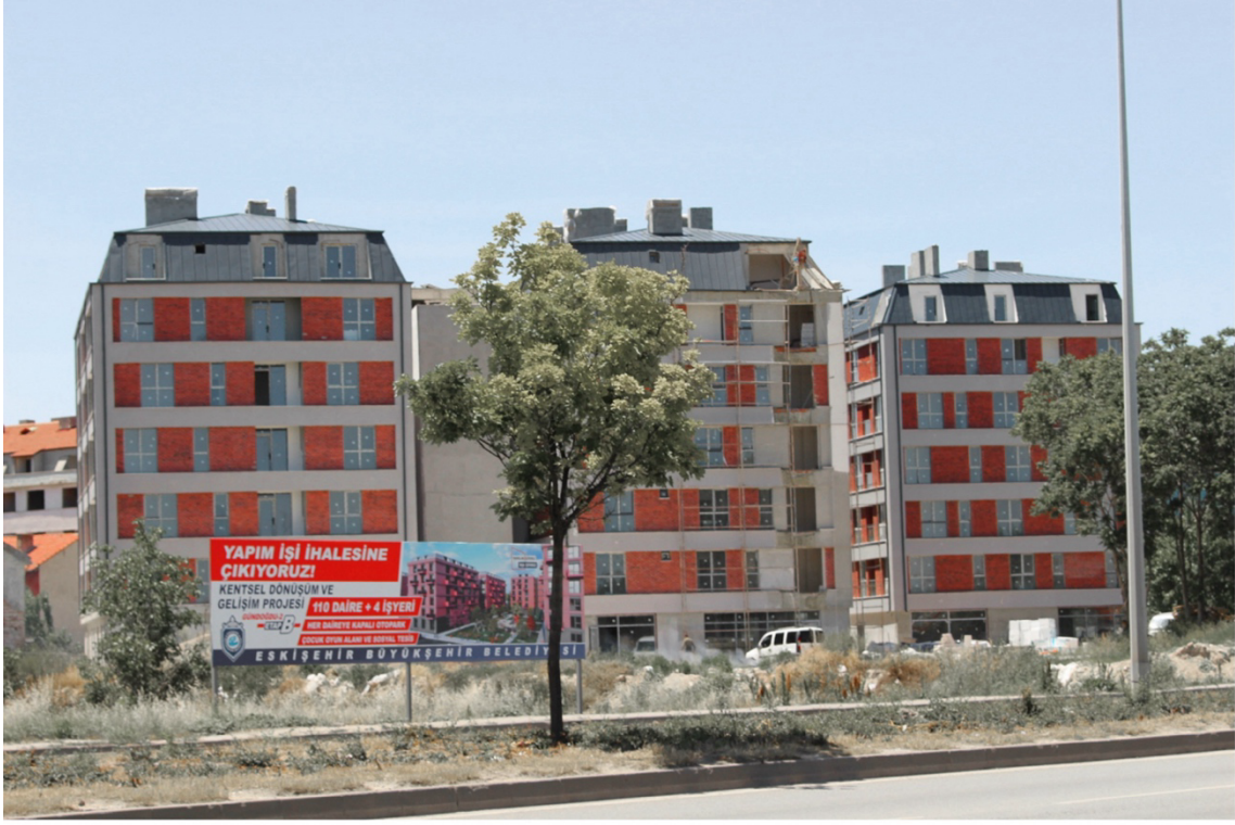
Görsel 4.9. Gündoğdu-2 Kentsel Dönüşüm Projesi Kapsamında Başlayan İnşaat İşleri
