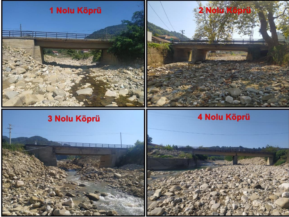
Şekil 68: Taşkın Analizinin Yapıldığı Kesitteki Köprüler
