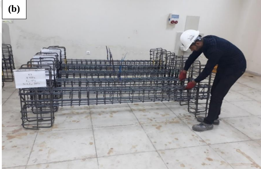
Şekil 3.6. Betonarme kolonların donatılarının bağlanması.
