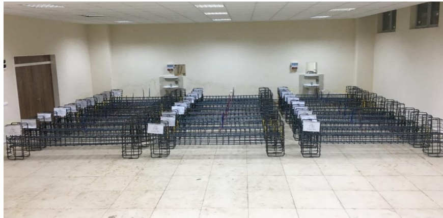
Şekil 3.7. Hazır hale getirilen betonarme kolon donatı kafesleri.
