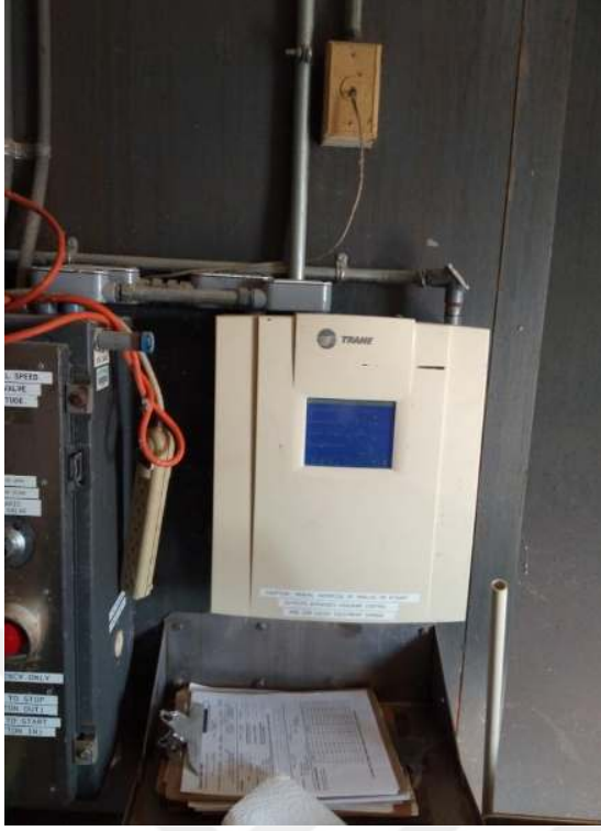
Şekil-4: Çevresel faktörlerin kayıt altına alınarak izlendiği monitör
