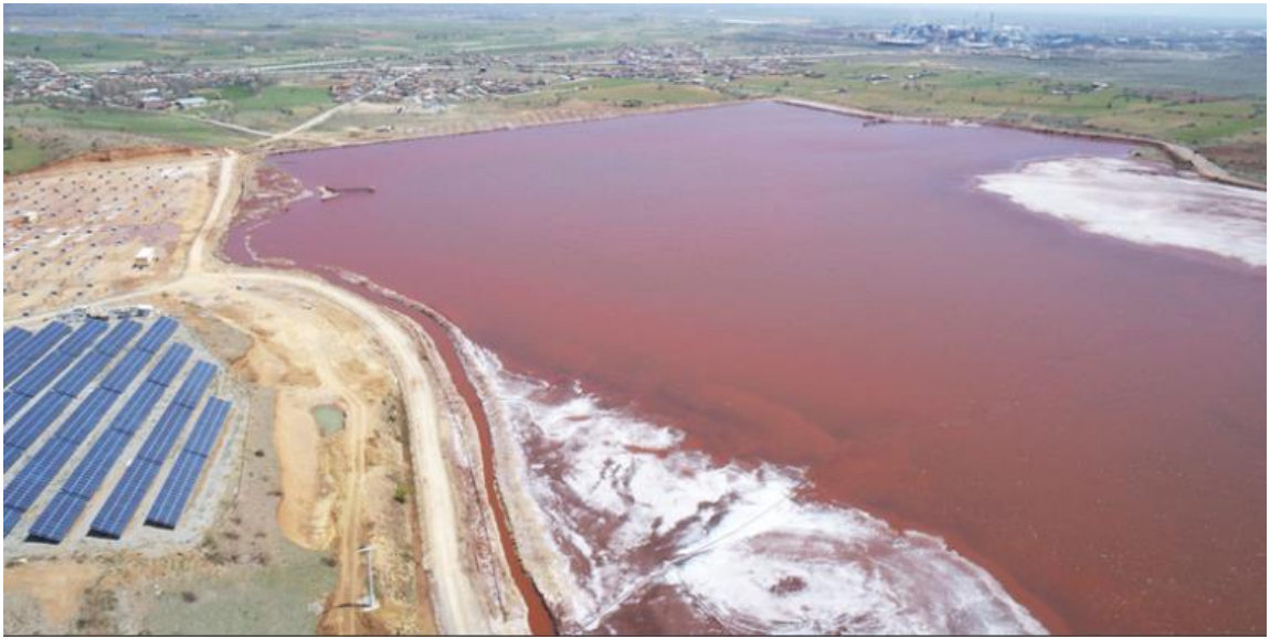
Şekil 2.7. Seydişehir Eti Alüminyum A.Ş. kırmızı çamur barajı
