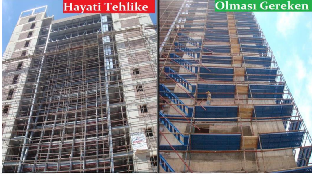
Şekil 3.20 Doğru ve Yanlış İskele Kurulumu
