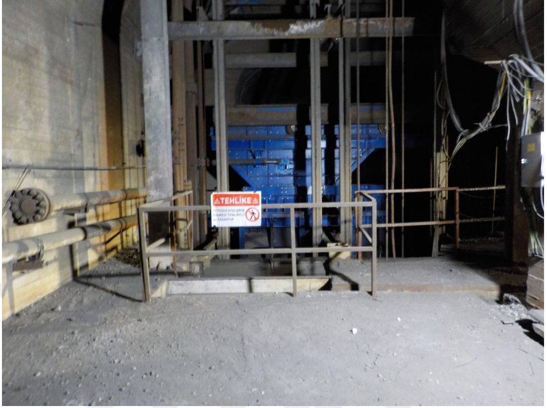
Şekil 3.19 Yeraltı Şaft İşlerinde Kullanılan Geçici Korkuluk
