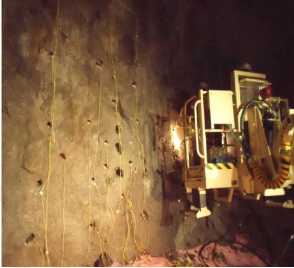
Şekil 3.11 Normet ile Ayna Dolumu
