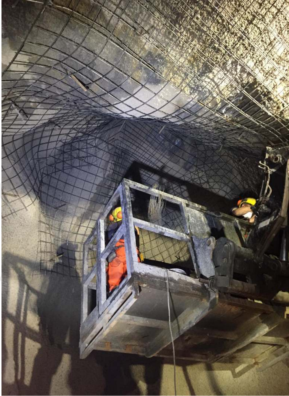
Şekil 3.12 Sehbanın Ulaşamadığı Yerde Tahkimat Yapımı
