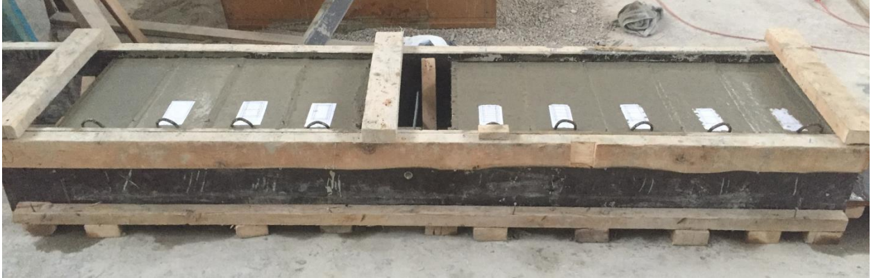
Şekil 2.12. Kalıpların betonlama işleminden sonraki görünümü
