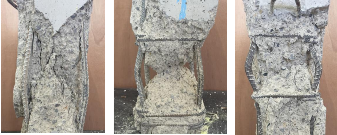
Şekil 3.2. Numunelerde boyuna donatı burkulması
