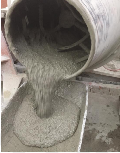
Şekil 2.9 Taze betonun betonyerden alınması
