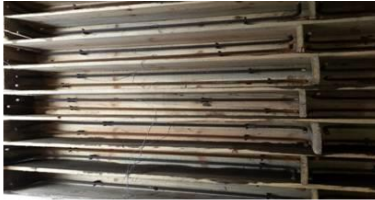
Şekil 2.2 Beton dökülmeden önce kalıplar ve donatı yerleşimi
