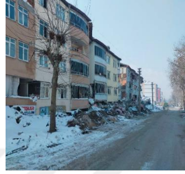
(b) Yumuşak kat düzensizliği kaynaklı hasarlar
