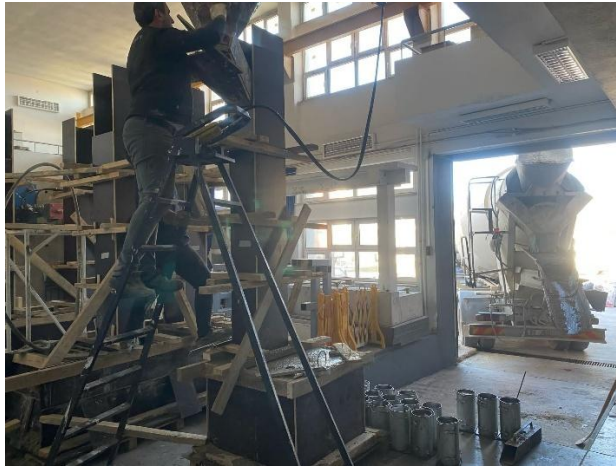
Görsel 3.8. Beton dökümü ve kalıp sökümü
