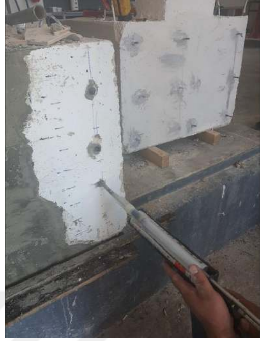
(c) Çelik plakalar için kimyasal dübel uygulaması
