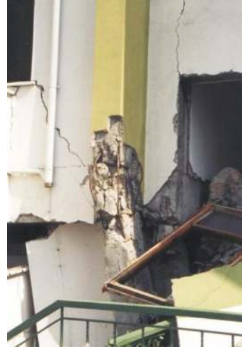
(f) Etriye sıklaştırmalarının yetersiz olması (Saatçioğlu vd., 2001)
