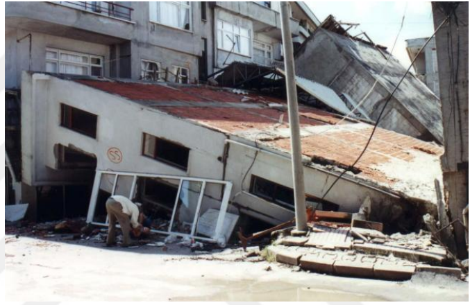
(b) Temel göçmesi (Bruneau vd., 2002)
