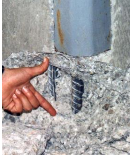
(e) Etriye sıklaştırmalarının yetersiz olması (Bruneau vd., 2002)
