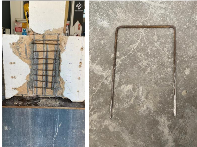
(a) U şeklinde bükülen donatıların yerleştirilmesi
