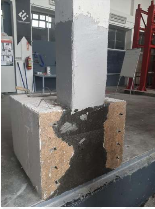
(f) Epoksi bazlı tamir harcı uygulaması
