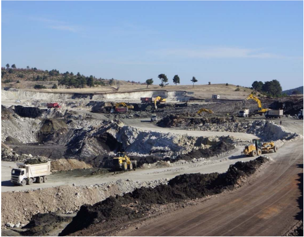
Şekil 6.7 Ayvalı-2 panosundaki çalışmadan görünüm
