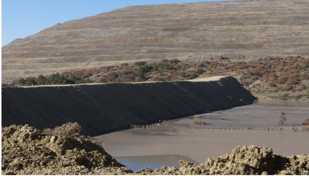
Şekil 6.9 2013 itibari ile çelikler tarafından yapılan kül barajı
