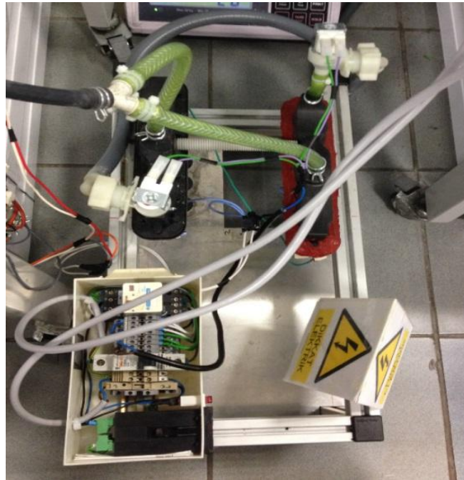
Şekil 4.12 Kullanılan buhar jeneratörlerinin üstten görünümü.
