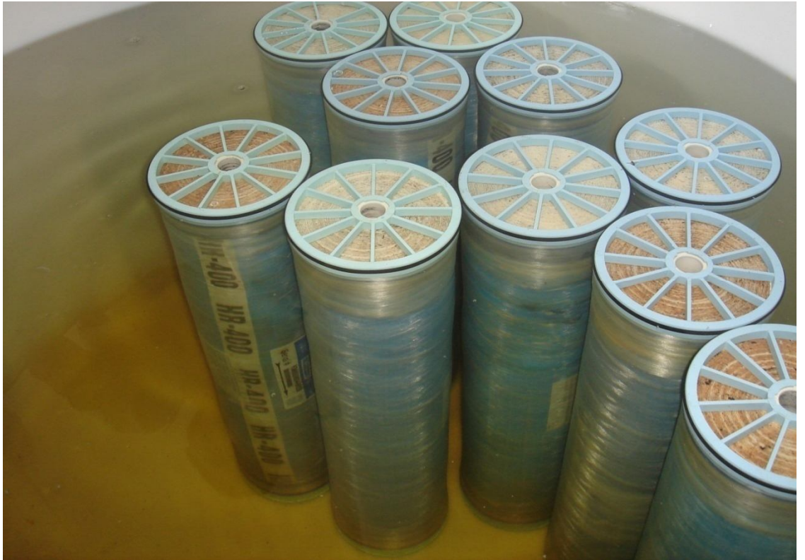
Şekil 2.10 Membran kartuşları (Konya Organize Sanayi İçmesuyu Arıtma Tesisi)
