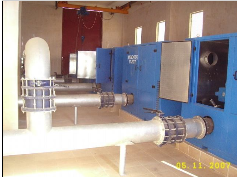
Şekil 3.4 Mahmutlar atıksu arıtma tesisi hava üfleyici motorlar
