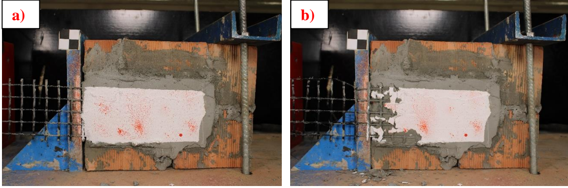
Resim 3.8. #8 deney elemanı: a) göçme öncesi, b) göçme sonrası
