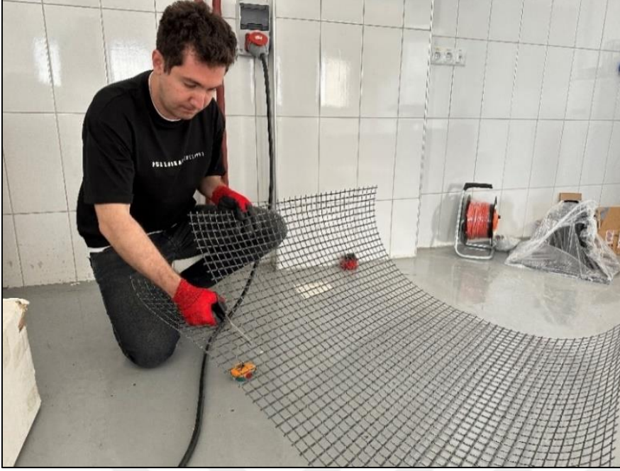
Resim 2.7. Farklı genişlik ve uzunluklardaki TDH şeritlerin kesilmesi
