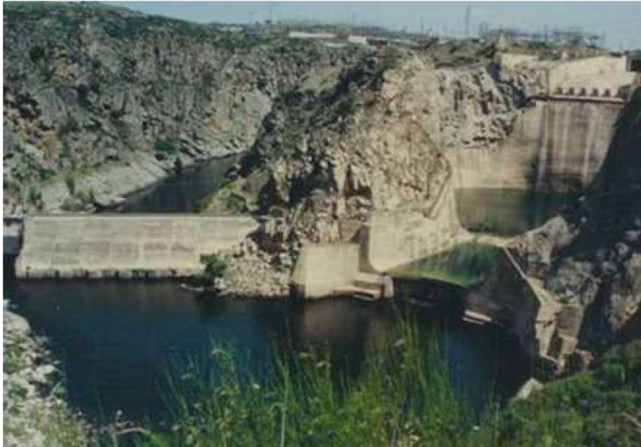
Şekil 2.14. Ricobayo Barajı'nın oyulmaya karşı iyileştirilmesi (George ve Sitar, 2012)
