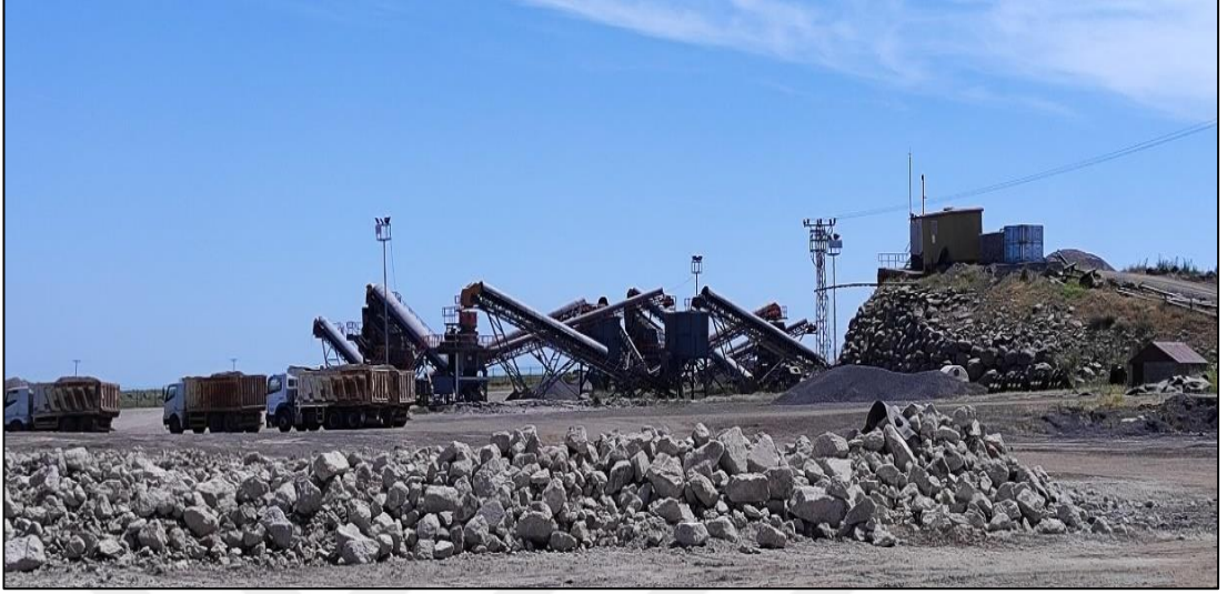
Şekil 3.8 Bağlar Belediyesi bazalt agregat tesisi
