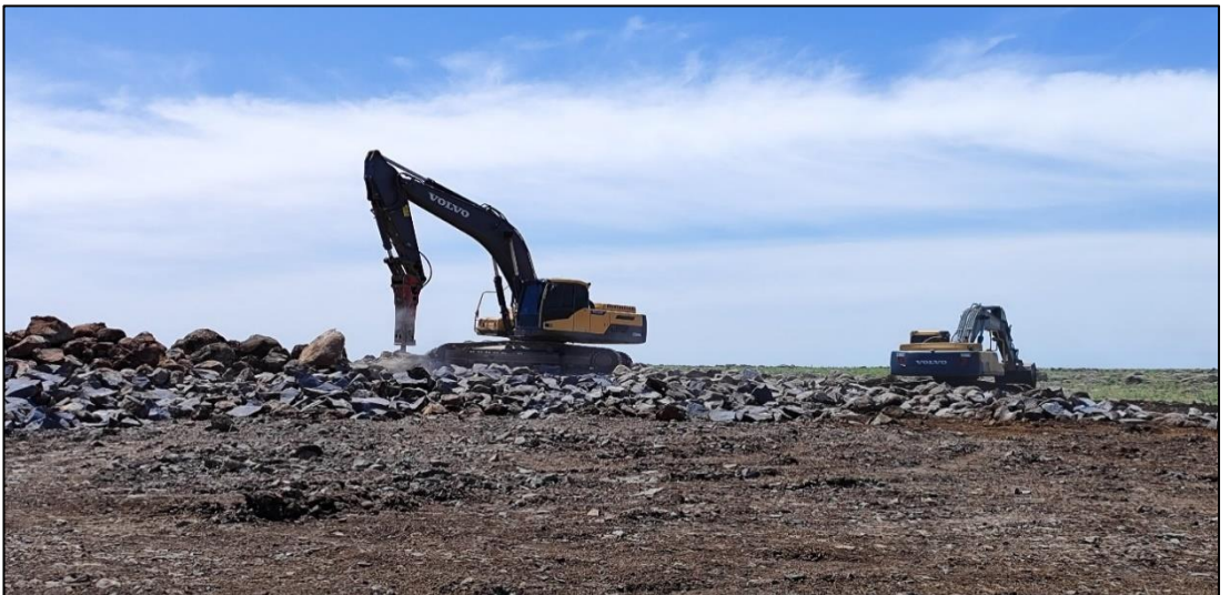
Şekil 3.3 Bazaltların kapladığı alandaki taşların kırılması
