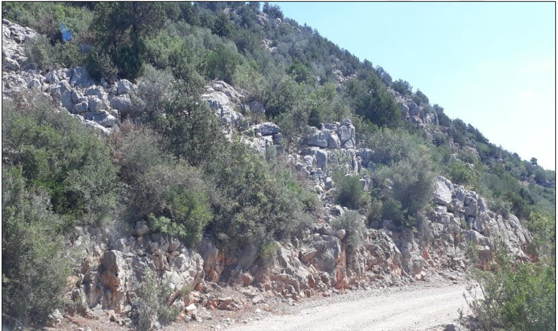
Şekil 3.2. Gri-koyu gri-kül renkli çok çatlaklı, kırıklı ve bloklu bir yapıya sahip olan Demirkazık formasyonuna ait kireçtaşlarının makiliklerle örtülü mostra yüzeyi
