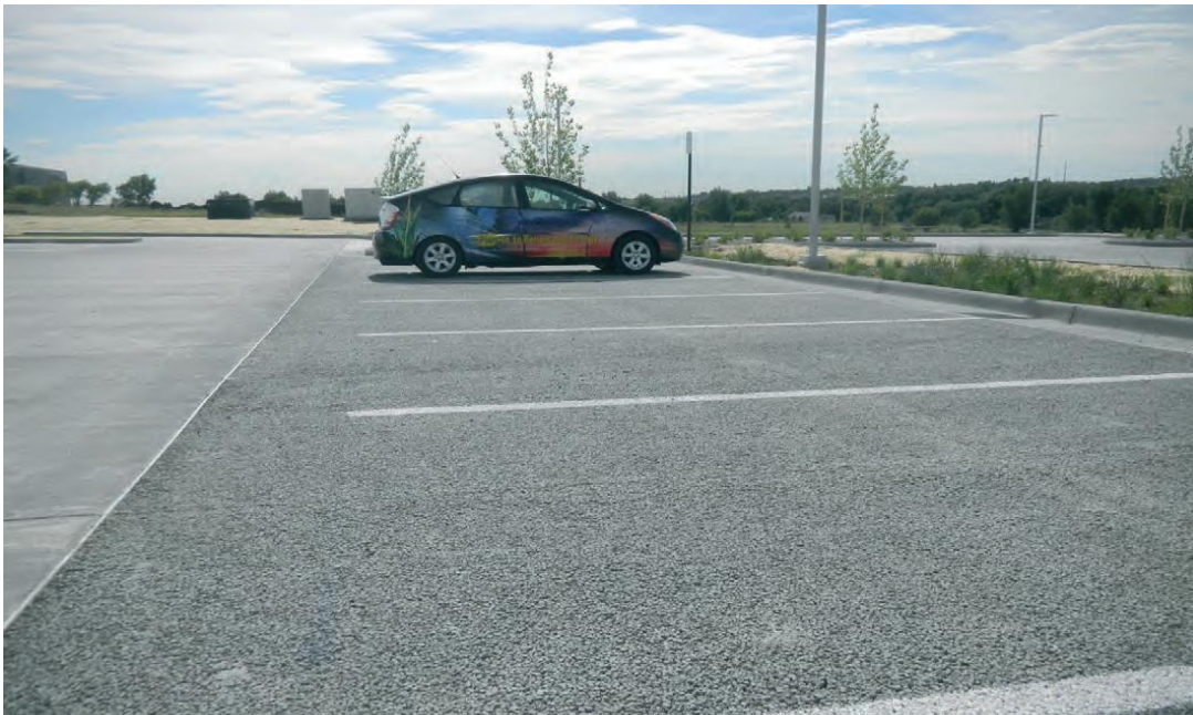
Resim 2.2 Geçirimli beton uygulanmış bir otopark alanı (Çevre ve Şehircilik Bakanlığı 2018).
