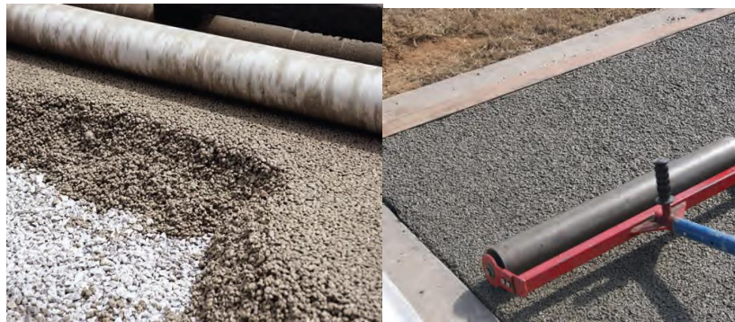
Resim 2.4 Geçirimli betonun silindirle sıkıştırma işlemi (Çevre ve Şehircilik Bakanlığı 2018).
