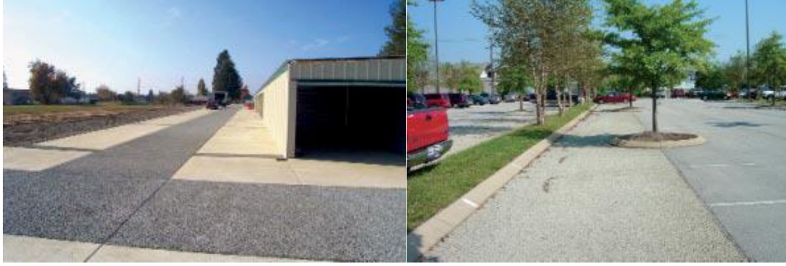
Resim 2.3 Geçirimli beton uygulanmış yürüyüş yolu ve kaldırım (Tennis vd. 2004).
