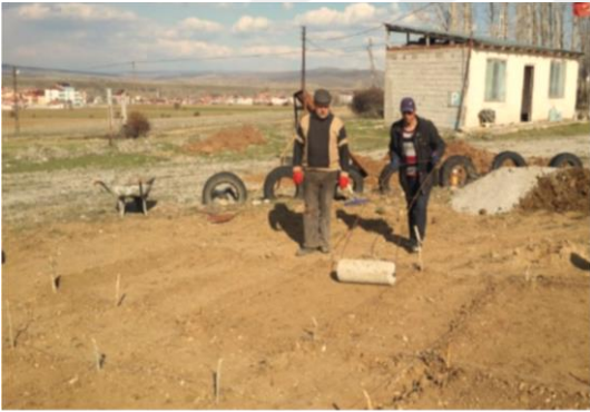
Şekil 2.7. Sıkıştırma işleminin yapılması
