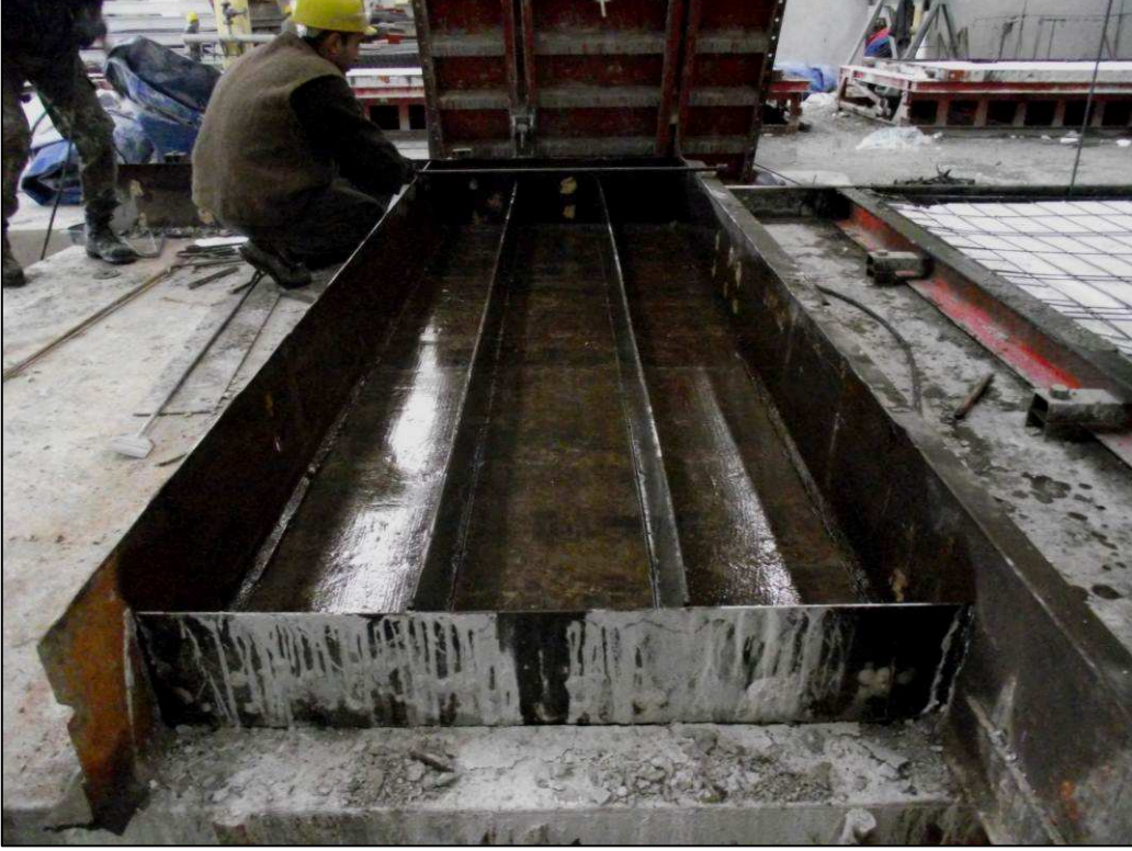
Resim 4.2 Betonarme kirişlerin kalıplarının hazırlanması
