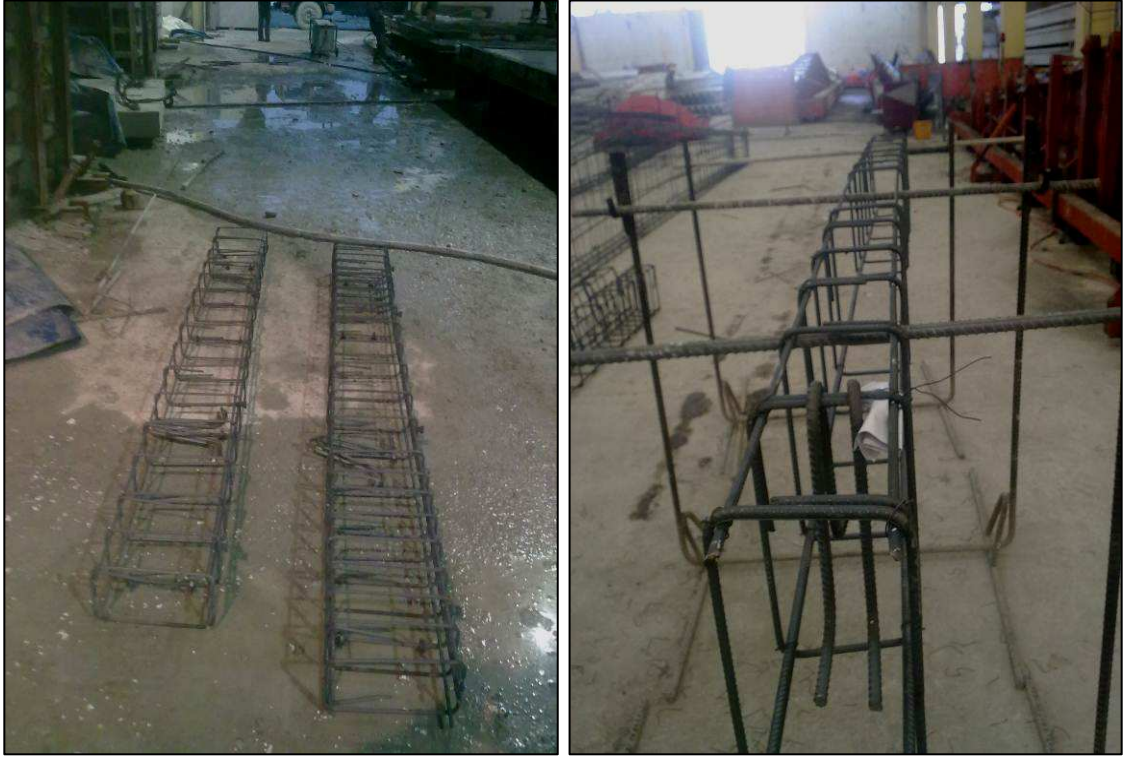
Resim 4.1 Betonarme kirişler donatılarının hazırlanması
