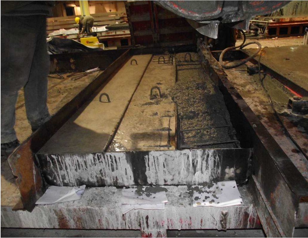
Resim 4.3 Betonarme kirişlerin betonlanması
